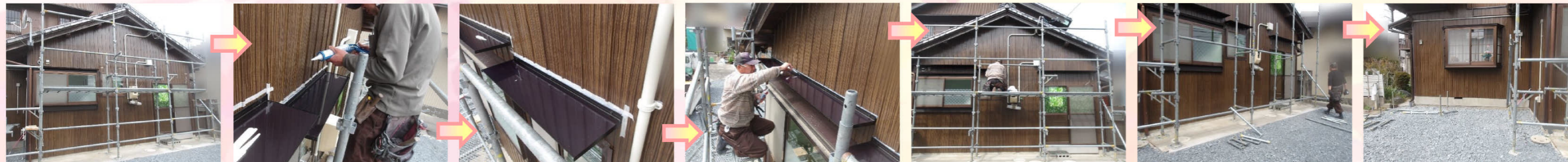
既設の窓の上に小庇を取り付けていきます。
