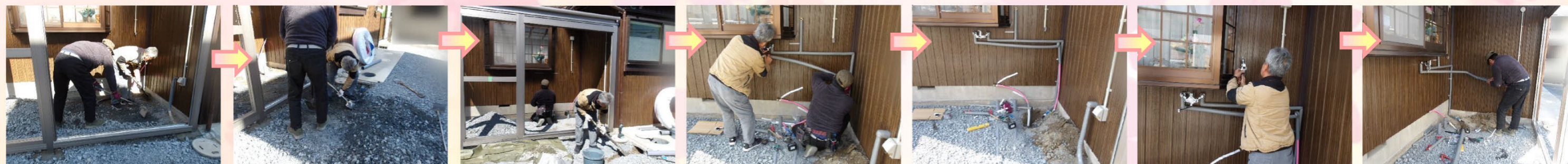
テラス内には洗濯機や流し台を設置するので、コンクリート土間を打設する前に給排水管工事を行います。
