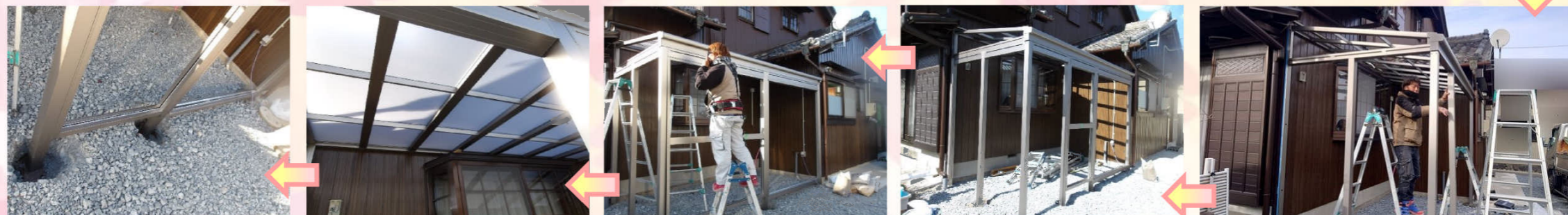
テラスの形が出来上がってきました。
