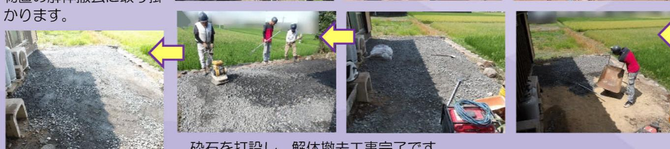
碎石を打設し、解体撤去工事完了です。
