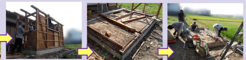
当初は経年劣化していた屋根や壁の鋼板を撤去し、新しくガルバリウム鋼板を張って修繕する予定でしたが、柱や床の腐食が激しかったので物置自体を全て解体撤去することになりました。
