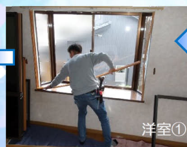
出窓には内窓を設置します。
