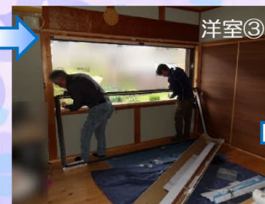
出窓には内窓を設置します。
