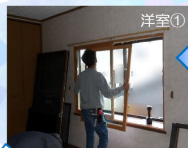
出窓には内窓を設置します。
