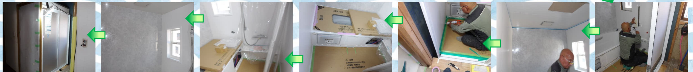
キズや汚れが付かないように養生をして、ユニットバス設置工事完工です(^)/
