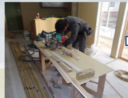
巾木を取り付けていきます。寸法を確認しながら巾木を加工し、取り付けていきます。
