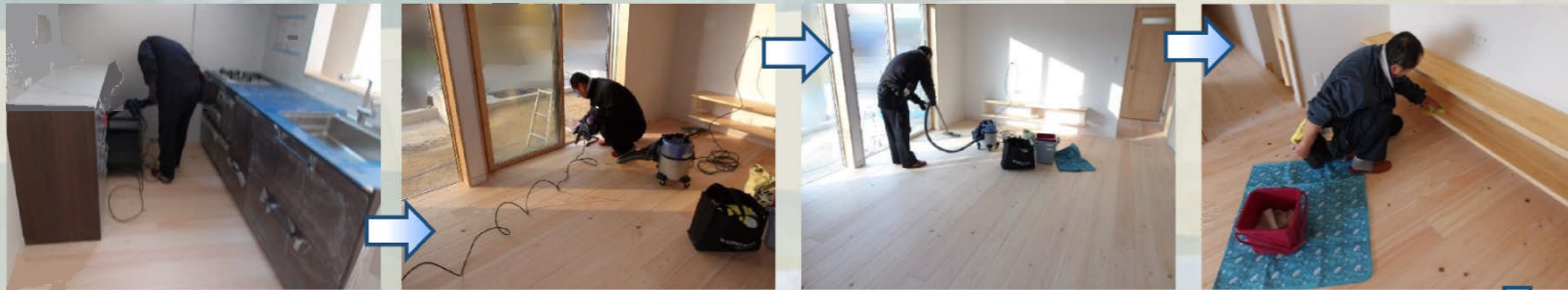
養生板を撤去後、清掃です！
