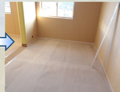
巾木を取り付けていきます。寸法を確認しながら巾木を加工し、取り付けていきます。
