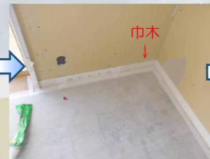
巾木を取り付けていきます。寸法を確認しながら巾木を加工し、取り付けていきます。
