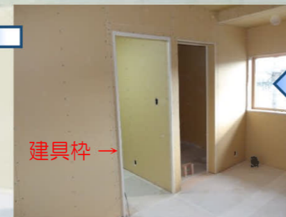
建具枠や収納スペースの中段、収納棚などを取り付けます。
