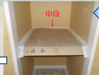
建具枠や収納スペースの中段、収納棚などを取り付けます。
