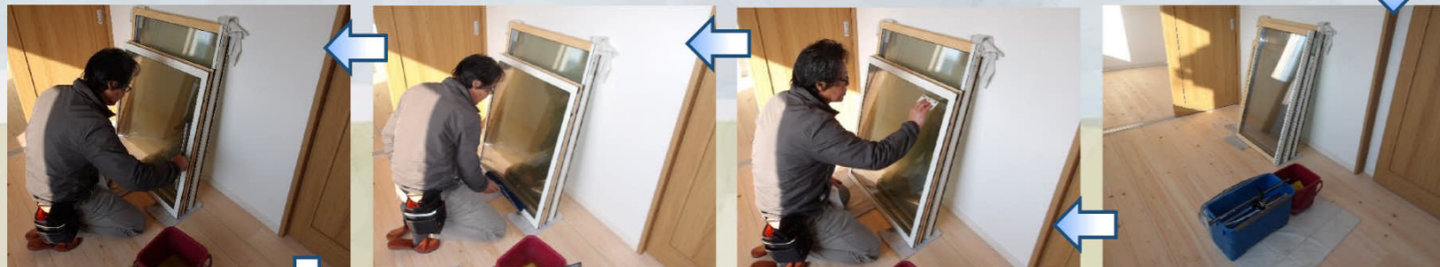
サッシは取り外し、何種類かの道具を使ってきれいに拭き上げます。
