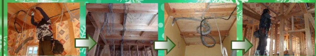
電気の仕込み配管を行います。天井や壁に配線が張り巡らされていきます。
