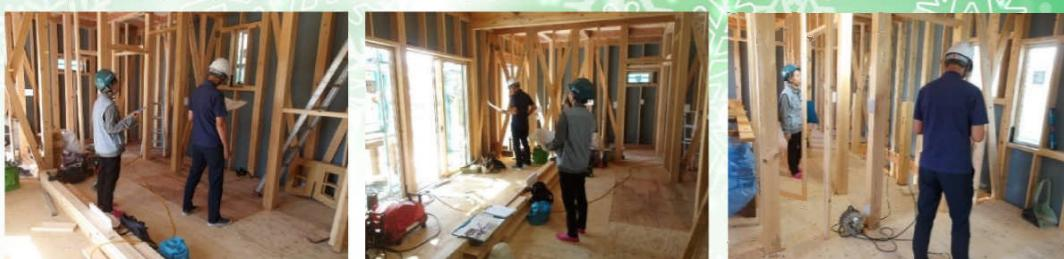
建設の住宅性能評価を受けるため、建築士立会いのもと、第三者機関の検査員の検査を受けます。図面通りに施工されているかチェックしていきます。
