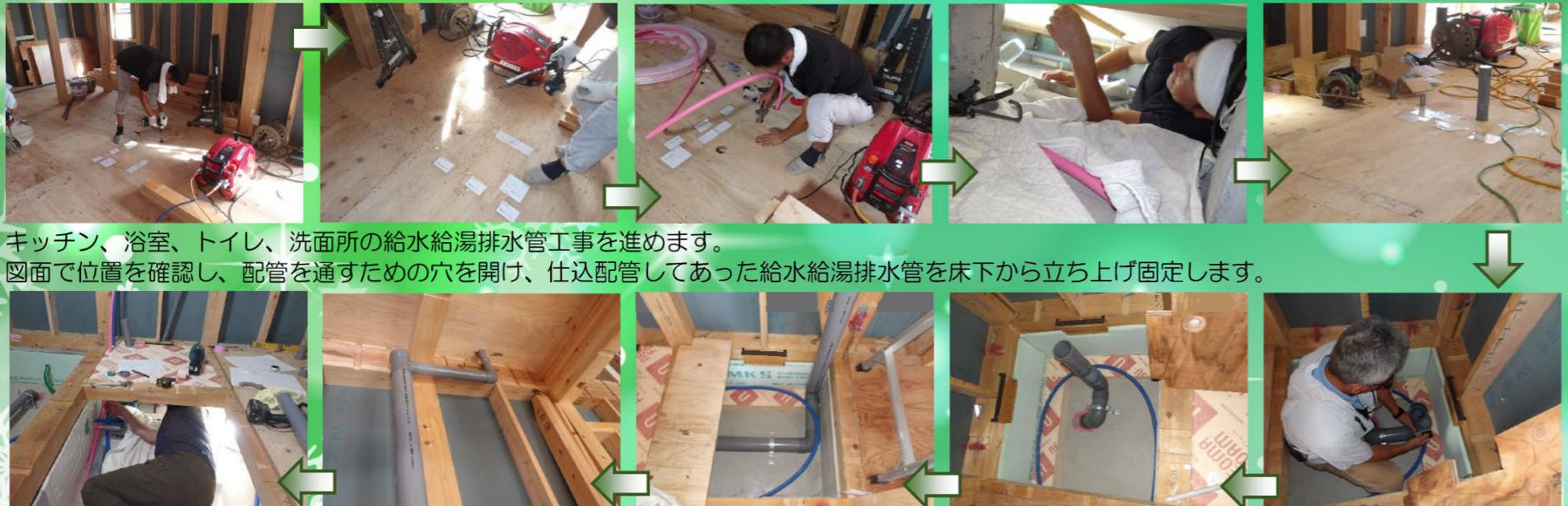
キッチン、浴室、トイレ、洗面所の給水給湯排水管工事を進めます。
