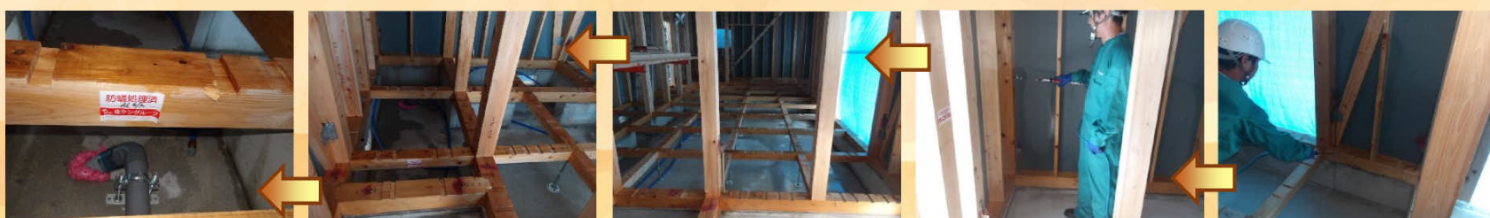
噴霧後、防蟻処理済のシールに施工日を記入し、柱や大引などに貼って終了です。
