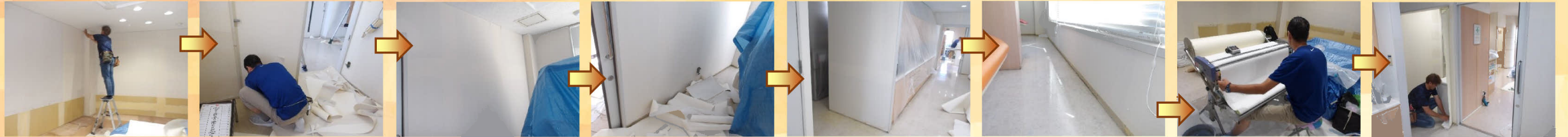
既設のクロスと巾木を撤去していきます。
