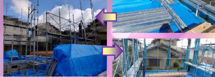
足場設置工事です。鋼管が運び込まれ、職人さんたちが手際よく足場を組み上げていきます。
