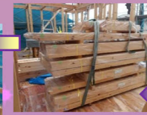
クレーンで1階の間柱や筋違い材を床に置きます。
