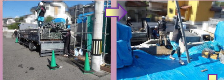
足場設置工事です。鋼管が運び込まれ、職人さんたちが手際よく足場を組み上げていきます。
