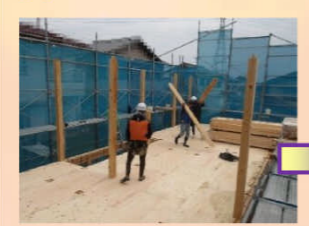
柱を建て、横架材を納めていきます。
