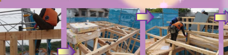
クレーンで1階の間柱や筋違い材を床に置きます。
