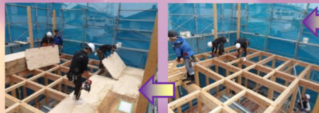
2階の床梁を納め、床下地板を貼っていきます。
