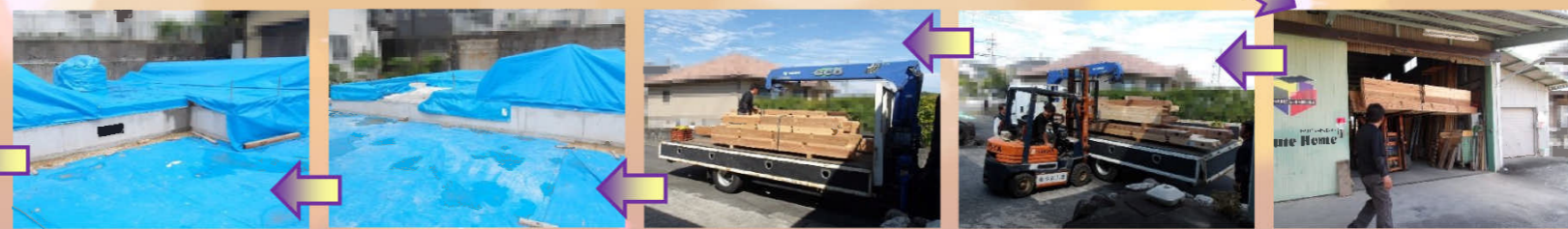
加工された構造材が次々とユニット車へ積まれていきます。
