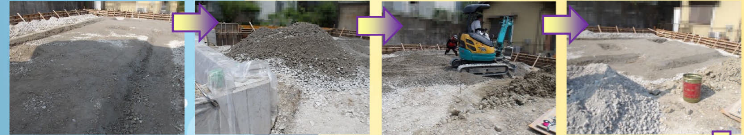
丁張を行い、掘削と鋤取り作業を行い敷地を均し、砕石を敷設して転圧機で締め固めます。
