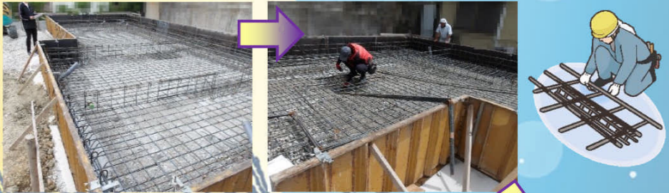
スリーブ管が設置され、配筋組みもラストスパートです。
