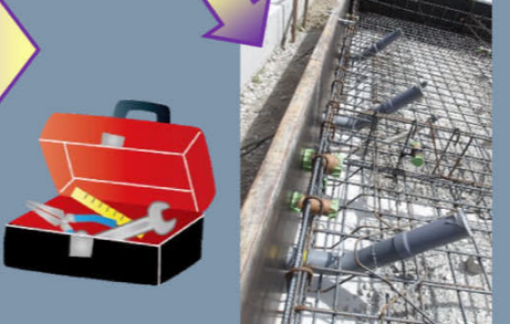
第三者検査機関の検査員による基礎配筋検査を受ける前に、弊社建築士が図面を基に自主検査を行います。
