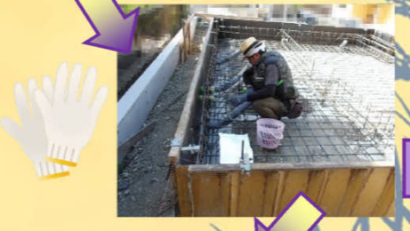
生コン打設前にスリーブ管を設置します。
