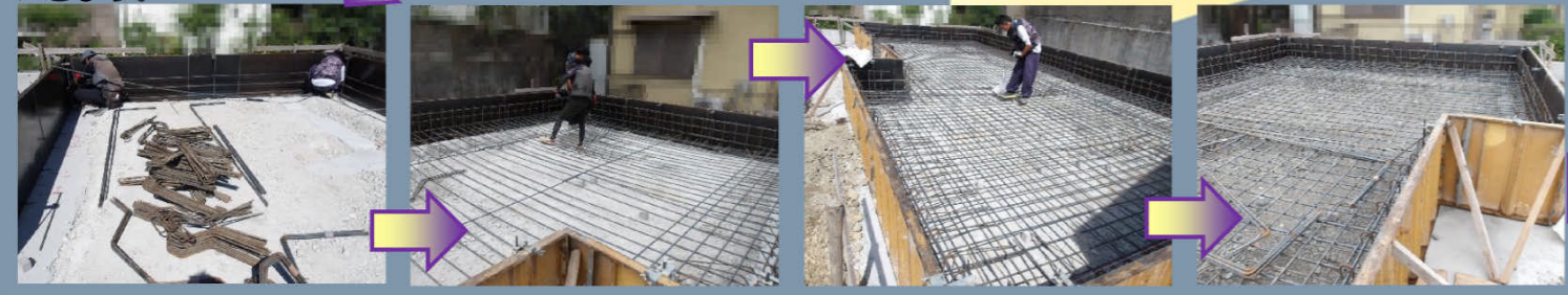
生コンが乾いたら型枠を組み、鉄筋を組んでいきます。
