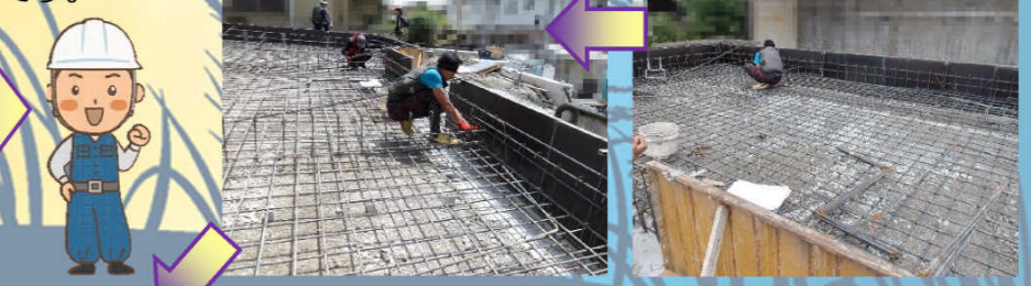
スリーブ管が設置され、配筋組みもラストスパートです。
