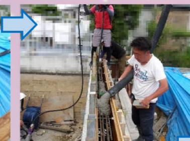
生コンがどんどん流れ込んでいきます。コンクリートに含まれる気泡を取り除く為、高周波バイブレーターと壁枠には壁打ちバイブレーターを使い、振動を加え締固めています。気泡が含まれたまま固まるとコンクリート内に隙間ができる可能性があるので隙間をなくすことで強度の高いコンクリートに仕上がります。
