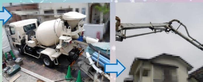
ミキサー車が到着し、立上り部分の打設開始です(^^)/
