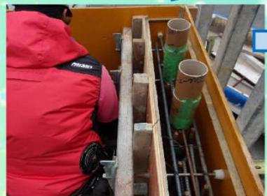
フェンス柱用穴抜のボイド管を取り付けていきます。
