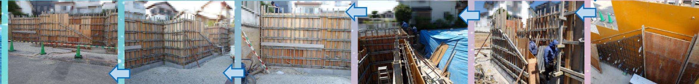
型枠設置完了です！生コン打設用の準備工を行います。
