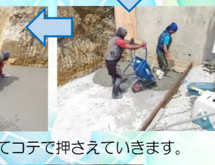
コンクリートを打設していきます。コンクリートを均してコテで押さえています。
