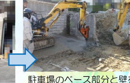
駐車場のベース部分と壁を解体撤去していきます。
