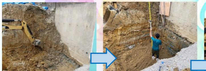
何回かに分け、地盤改良材をまんべんなく混ぜ、ランマーで締固める作業を繰り返していきます。
