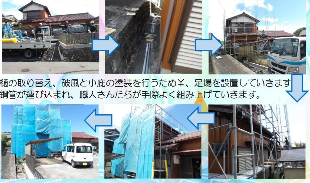
樋の取り替え、破風と小庇の塗装を行うため、足場を設置していきます
