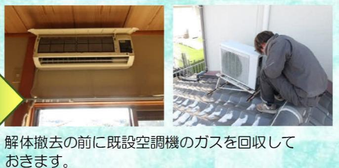
解体撤去の前に既設空調機のガスを回収しておきます。
