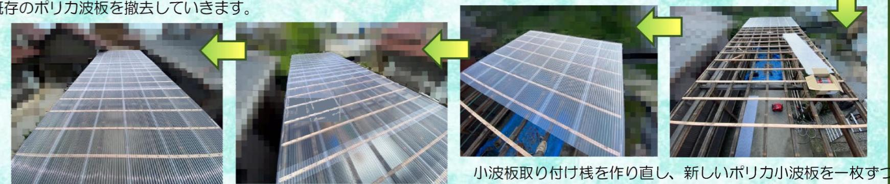
小波板取り付け枠を作り直し、新しいポリカ小波板を一枚ずつ
