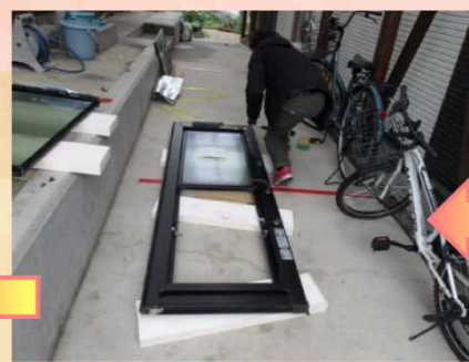
上部には新しいガラス、下部には既存のガラスをはめ込み、勝手口にドアを戻します。
