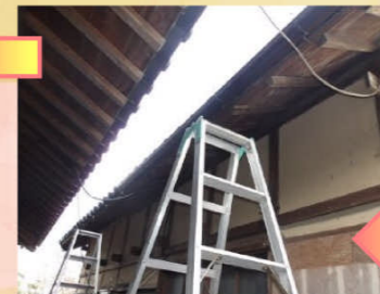
受け金具を取り付け、軒樋を取り付けていきます。
