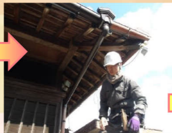
受け金具を取り付け、軒樋を取り付けていきます。
