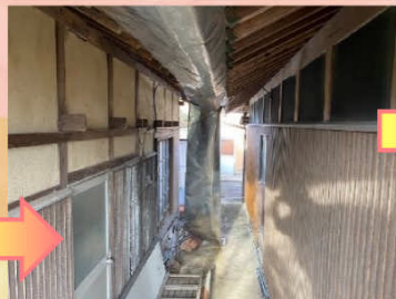
母家と離れの間に設置してあったステンレス製箱樋が外れ、垂れ下がっている状態でした。
