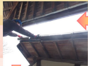
集水器を取り付けるため、樋を加工します。
