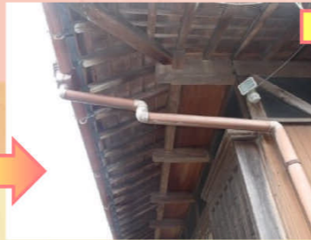
軒樋も経年劣化で傷んでいる状態でしたので今回の工事で取り替えます。
