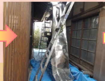
外れて垂れ下がっていたステンレス製箱樋を撤去していきます。
