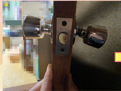
ドアレバーとラッチを取り外します。
