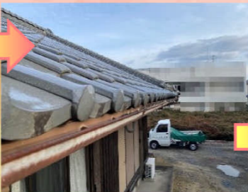
軒樋も経年劣化で傷んでいる状態でしたので今回の工事で取り替えます。
