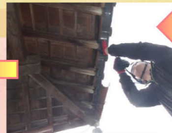
外れて垂れ下がっていたステンレス製箱樋を撤去していきます。
