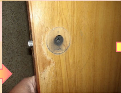
ドアレバーとラッチを取り外します。
