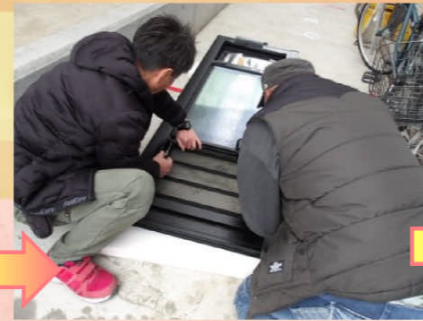
まずは割れていない下部のガラスを取り外します。
