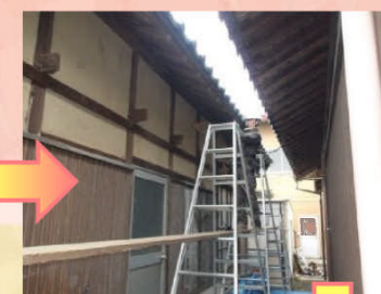
撤去完了です！ 今回の工事では母家と離れに軒樋を取り付けます。
