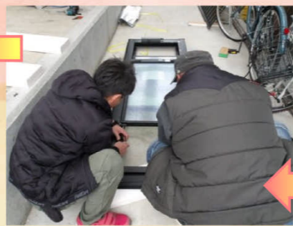
上部には新しいガラス、下部には既存のガラスをはめ込み、勝手口にドアを戻します。
