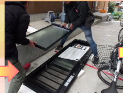
まずは割れていない下部のガラスを取り外します。
