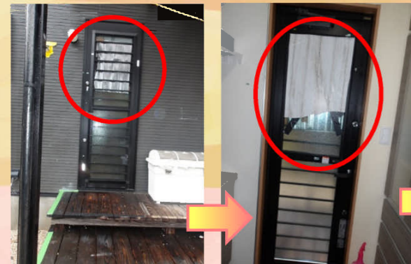
勝手口ドアを取り外します。
