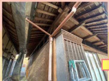
母家と離れの間に設置してあったステンレス製箱樋が外れ、垂れ下がっている状態でした。
