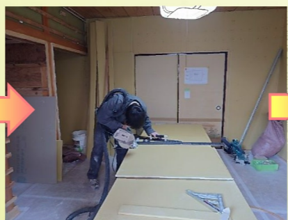
壁下地となる石膏ボードを寸法を確認しながら一枚ずつ加工して貼っていきます。
