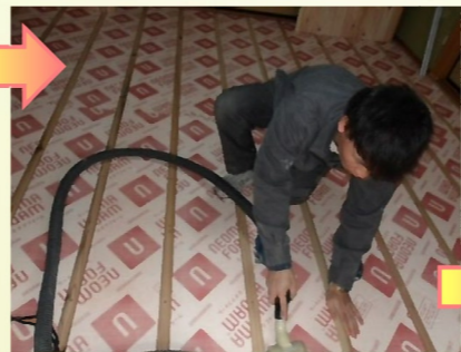
断熱材充填後、掃除を行い合板下地を寸法に合わせながら加工して貼っていきます。
