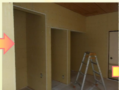
壁下地となる石膏ボードを寸法を確認しながら一枚ずつ加工して貼っていきます。
