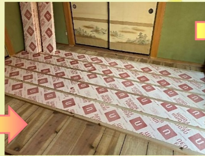
既設杉板の上に垂木を取り付けて嵩上げし、断熱材を充填します。
