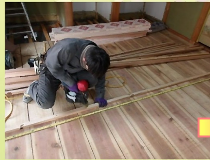
既設杉板の上に垂木を取り付けて嵩上げし、断熱材を充填します。
