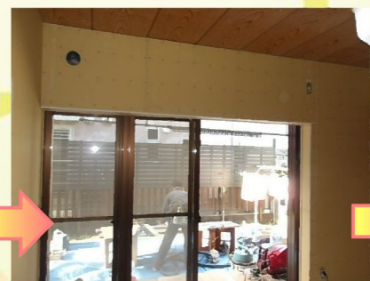
壁下地となる石膏ボードを寸法を確認しながら一枚ずつ加工して貼っていきます。
