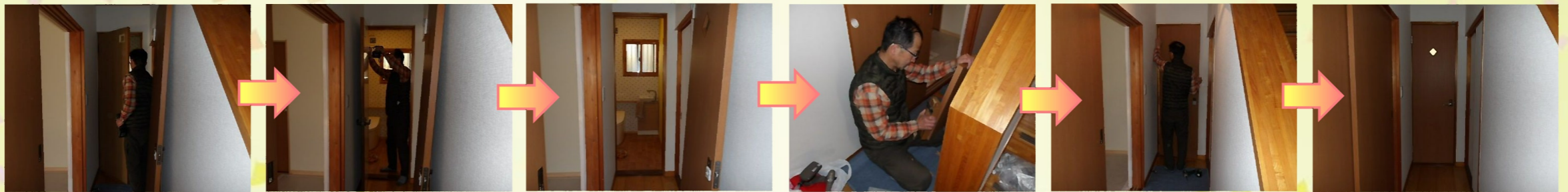
既存の敷居に新たにVレールを取り付けます。
