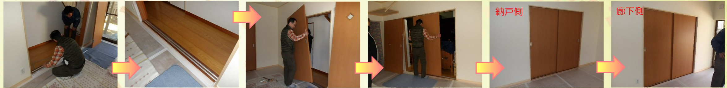
既存の敷居に新たにVレールを取り付けます。
