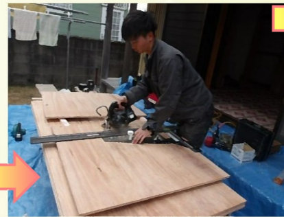
断熱材充填後、掃除を行い合板下地を寸法に合わせながら加工して貼っていきます。
