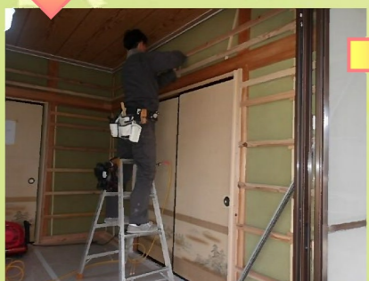
壁の木枠下地を取り付けていきます。
