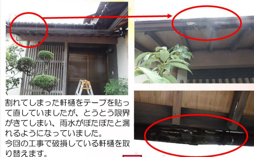
割れてしまった軒樋をテープを貼って直していましたが、とうとう限界がきてしまい、雨水がぼたぼたと漏れるようになっていました。今回の工事で破損している軒樋を取り替えます。
