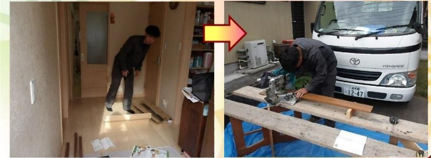
手摺取り付け用ベースプレートを取り付けていきます。
