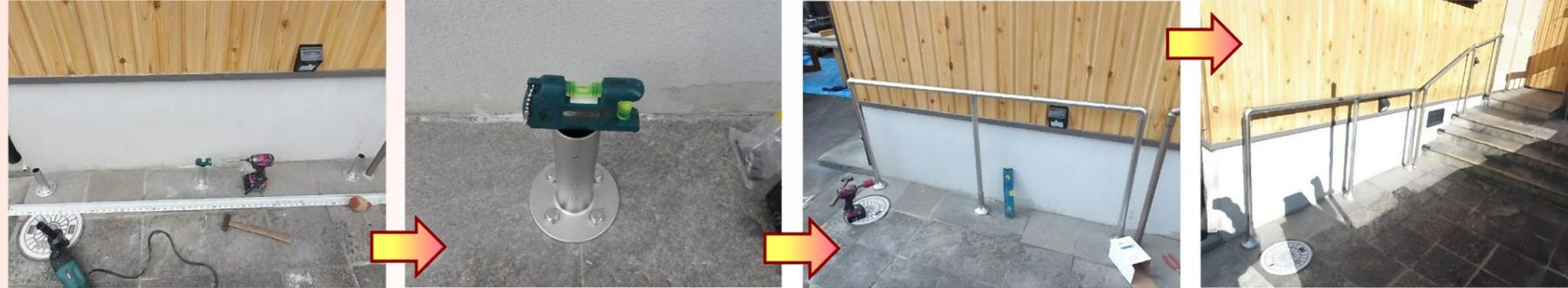
石貼り土間に穴を開け、支柱を取り付けていきます。
