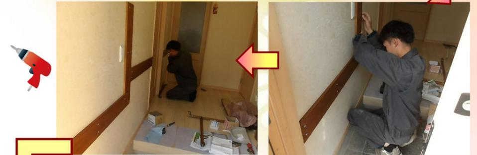
I型やし型の手摺を組み合わせてベースプレートに取り付けていきます。
