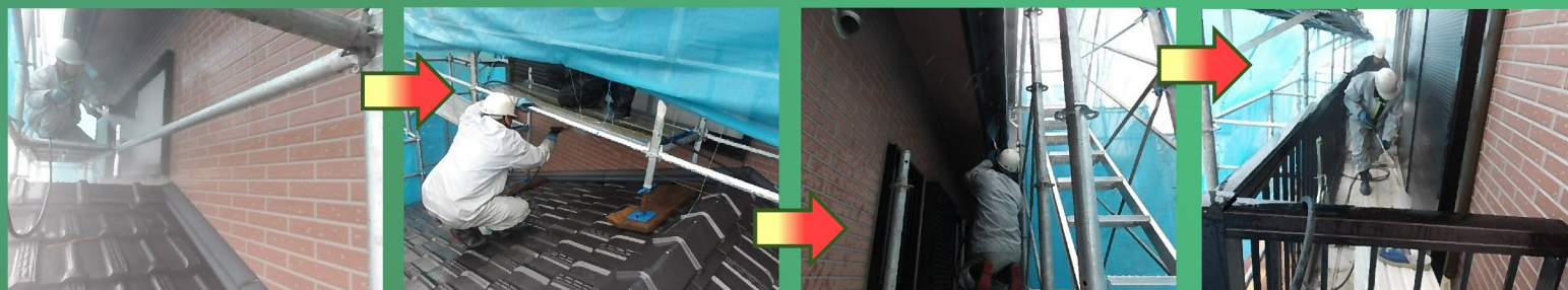
高圧洗浄機を使って長年の汚れなどを隅々まで洗い流します。
