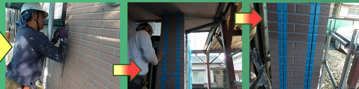
既存のコーキングを撤去し、マスキングテープで養生していきます。
