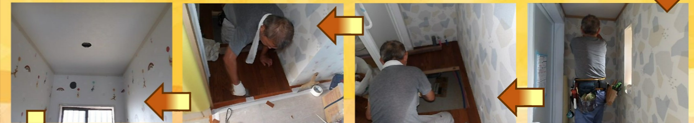
床にクッションフロア材を貼っていきます。
