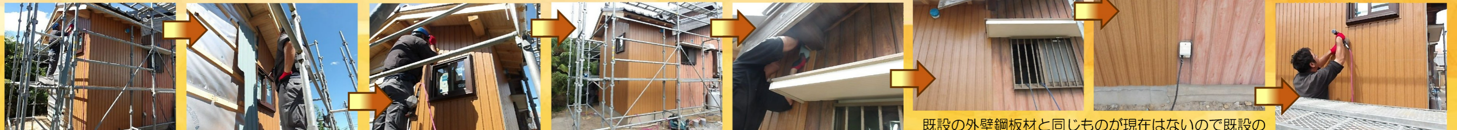
寸法を確認しながらGL鋼板を一枚ずつ貼っていきます。
