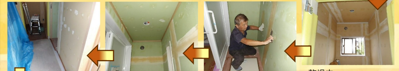
1回目のパテが乾いたら2回目のパテ処理を行います。
