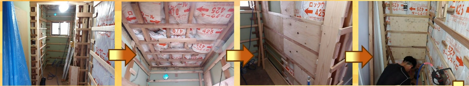
トイレ、洗面所、縁側の天井と壁に下地桟を取り付けてプラスターボードを貼っていきます。
