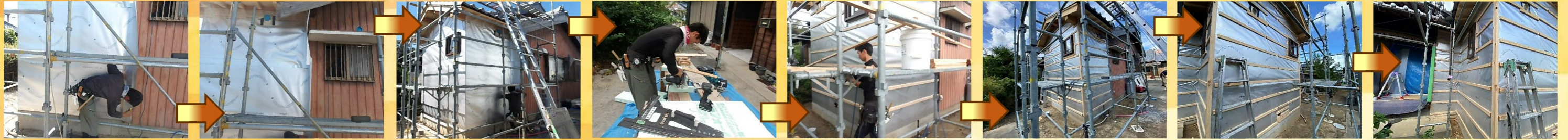
透湿防水シートを貼っていきます。
