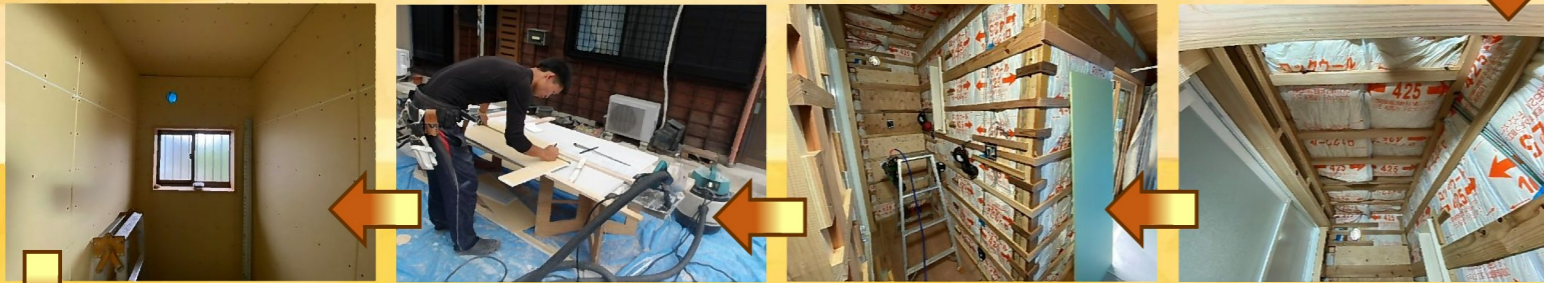
トイレ、洗面所、縁側の天井と壁に下地桟を取り付けてプラスターボードを貼っていきます。
