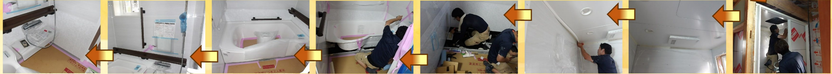
浴槽が運び込まれ、手摺りや水栓金具等を取り付け、システムバス設置完了です(◡)v
