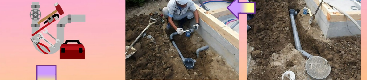
埋設管の為の掘削を行い、増築部分の浴室と洗面所の排水管を既設排水管へ 繋いでいきます。
