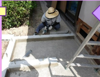
型枠をばらして立ち上がり部の角をサンダーで削ってを整え、基礎周りに一時撤去していた土を戻して工事完了です。
