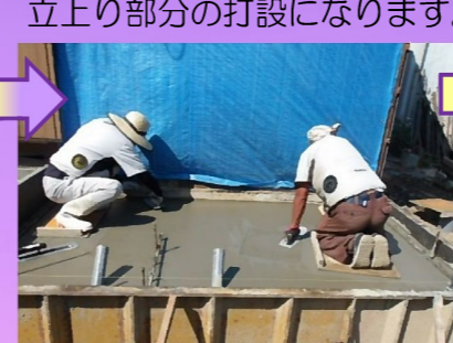
コテ押さえを行い、土間打設完了です。2～3日の養生期間後、立上り部分の打設になります。
