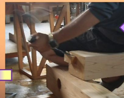
刻み加工が終わったら仮組ををしてぴったり納まるように微調整を行います。
