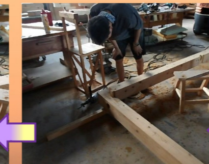
刻み加工が終わったら仮組ををしてぴったり納まるように微調整を行います。
