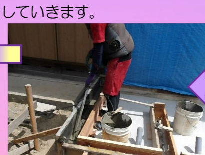
土間が乾いたら立上り部分の型枠を組んでいきます。
