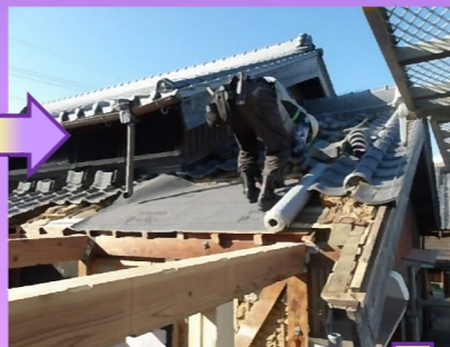
屋根にルーフィングを敷いて…
