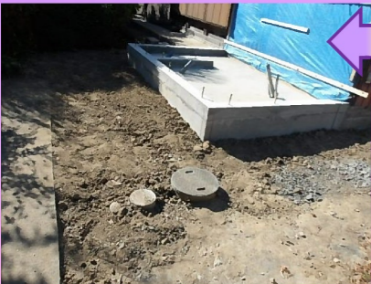
型枠をばらして立ち上がり部の角をサンダーで削ってを整え、基礎周りに一時撤去していた土を戻して工事完了です。
