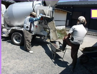
生コンを一輪車で運び、土間を打設していきます。
