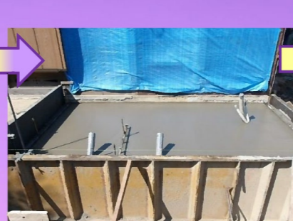
コテ押さえを行い、土間打設完了です。2～3日の養生期間後、立上り部分の打設になります。
