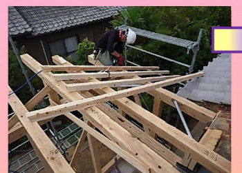
垂木を取り付けていきます。屋根のかたちが出来上がっていきます。
