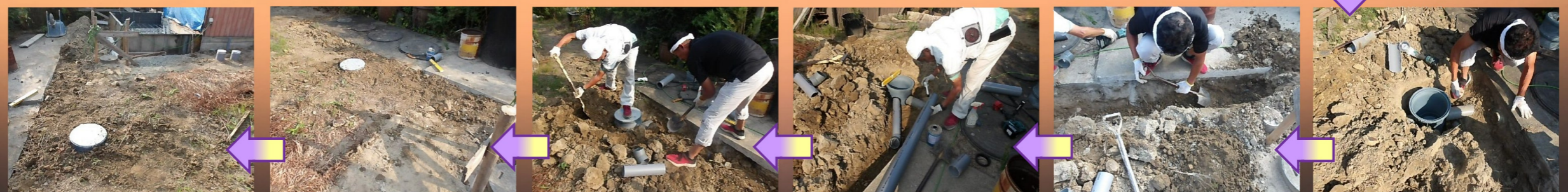
土間の生コン打設前に給排水管を設置します。
