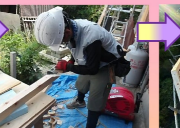
垂木を取り付けていきます。屋根のかたちが出来上がっていきます。
