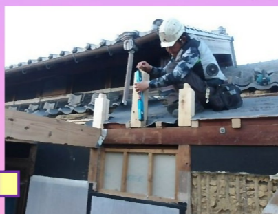
小屋束を建て、傾きがないか水平器で確認します。
