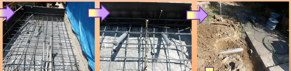
土間の生コン打設前に給排水管を設置します。
