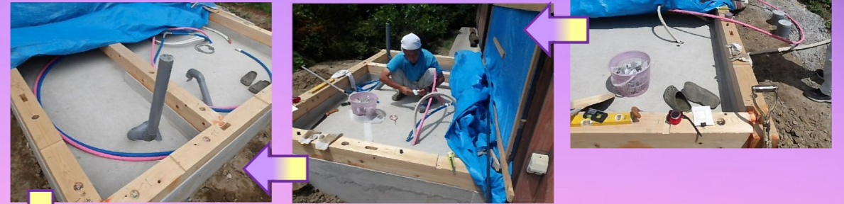
土台敷きが終わり、建前までの間に配管工事を行います。 基礎打設前に仕込んでおいた空管を実管に繋げます。
