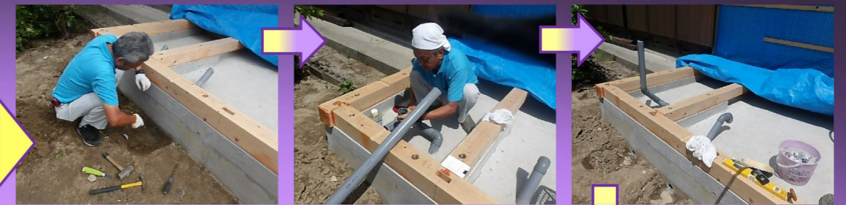
土台敷きが終わり、建前までの間に配管工事を行います。 基礎打設前に仕込んでおいた空管を実管に繋げます。
