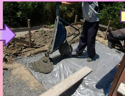
捨てコンクリートを打設します。
