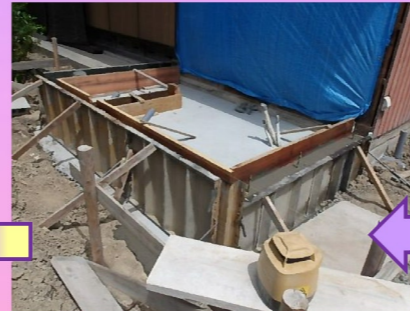
型枠をばらして立ち上がり部の角をサンダーで削ってを整え、基礎周りに一時撤去していた土を戻して工事完了です。
