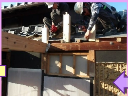
小屋束を建て、傾きがないか水平器で確認します。
