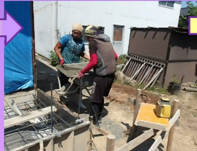
生コンを一輪車で運び、土間を打設していきます。
