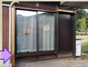
GL 鋼板を貼って大工工事完了です。 雨戸と網戸の納品を待つばかりです。
