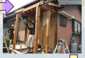
既存部分の解体後、開口を合板で塞ぎ、ブルーシートで養生しておきます。
