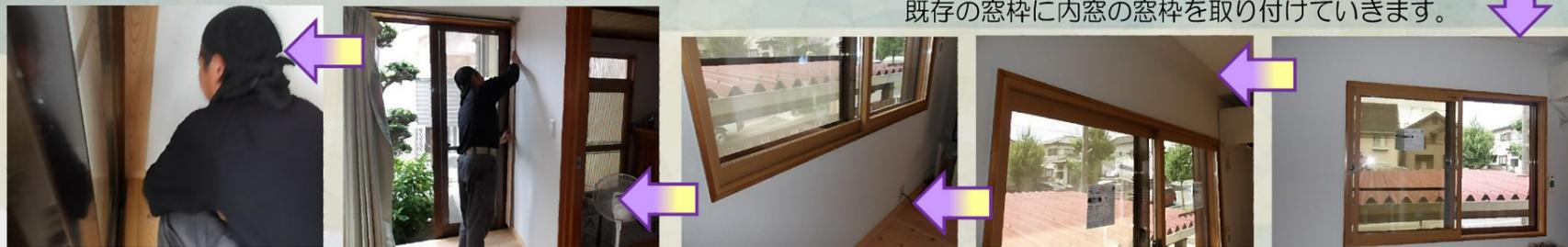
掃き出し窓に取り付ける前に幅木厚調整の為の方立を取り付けます。
