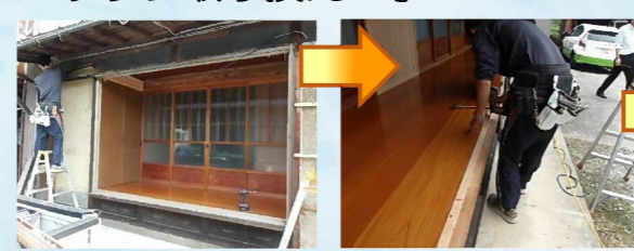
突然の雨に備え、1か所ずつ取り換えて いきます。既設サッシと雨戸を取り外し、 床高上げ下地を取り付けます。
