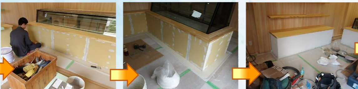
パテ処理を行ってから、下地材を塗布していきます。
