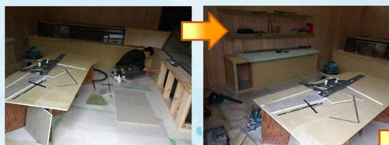
ショーケースを囲んだカウンターは珪藻土で仕上げるため下地材の石膏ボードを貼っていきます。
