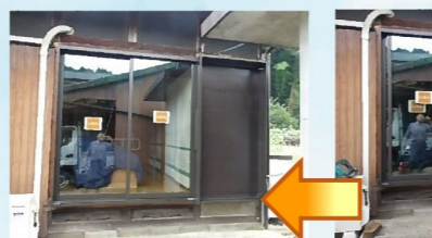
突然の雨に備え、1か所ずつ取り換えて いきます。既設サッシと雨戸を取り外し、 床高上げ下地を取り付けます。
