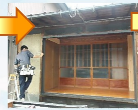
新しいサッシを取り 付けます。
