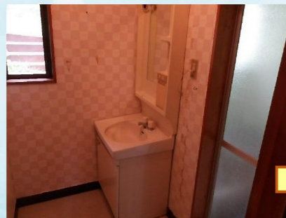
既設の洗面化粧台を撤去していきます。
