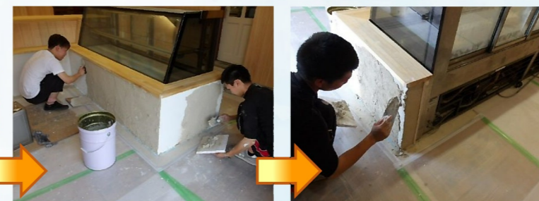
下地材が乾いてから、仕上げ材の珪藻土を塗布していきます。
