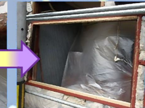
サッシは取り替えるので既設サッシを撤去し、窓枠のケレン掛けを行い、錆止め塗装をしておきます。
