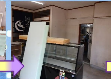
解体を始める前に搬出できないショーケースの養生をしておきます。ショーケースのサイズに合わせて枠組を作り、緩衝材を取り付け、ブルーシートでくるんでおきます。
