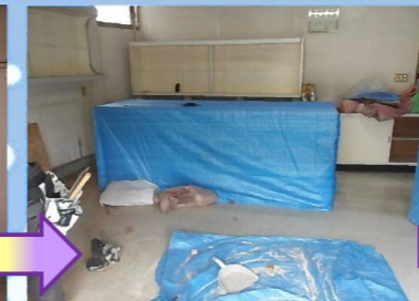
解体を始める前に搬出できないショーケースの養生をしておきます。ショーケースのサイズに合わせて枠組を作り、緩衝材を取り付け、ブルーシートでくるんでおきます。
