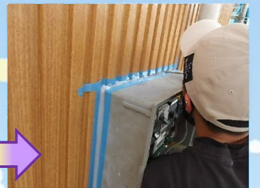
電圧をチェックし、ボックスの周りをコーキングで充填します。
