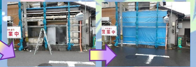
新しいサッシを取り付けるまでの間、ブルーシートで養生しておきます。
