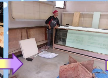
解体を始める前に搬出できないショーケースの養生をしておきます。ショーケースのサイズに合わせて枠組を作り、緩衝材を取り付け、ブルーシートでくるんでおきます。
