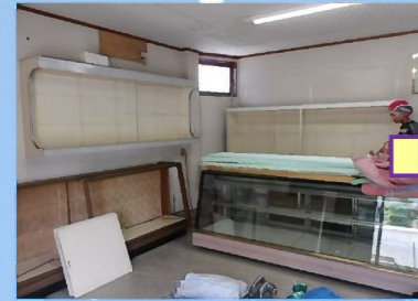
店舗内の工事を進めます。天井と壁の陳列棚を解体撤去します。
