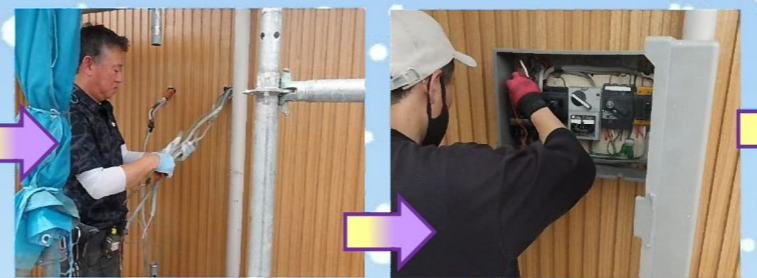
配線を整理し、ブレーカーなどを取り付けます。
