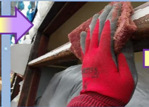
サッシは取り替えるので既設サッシを撤去し、窓枠のケレン掛けを行い、錆止め塗装をしておきます。
