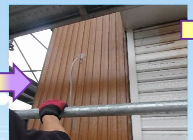
新たに設置する看板を照らすための屋外照明器具を新設します。
