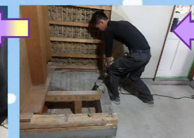
床をフラットにする為、基礎部分を研り機を使って壊し、鉄筋を切断しておきます。
