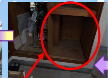
店舗内にあった物入を半分だけ解体撤去します。
