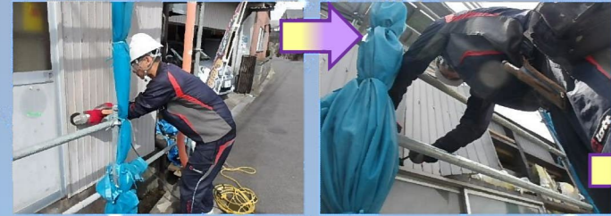
店舗横の製菓工場の既設鋼板壁を撤去します。
