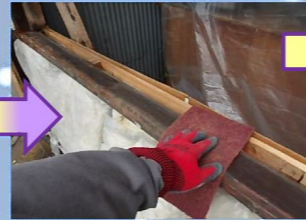
サッシは取り替えるので既設サッシを撤去し、窓枠のケレン掛けを行い、錆止め塗装をしておきます。
