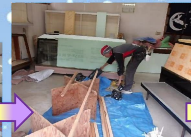
床をフラットにする為、基礎部分を研り機を使って壊し、鉄筋を切断しておきます。
