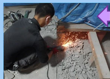
床をフラットにする為、基礎部分を研り機を使って壊し、鉄筋を切断しておきます。
