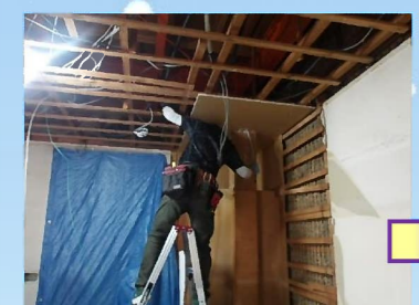
既設の配線を撤去し、新たに配線し直していきます。
