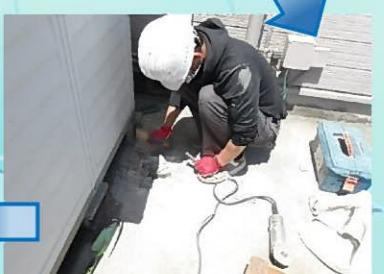
柱跡をモルタルで打設し解体撤去工事完了です。
