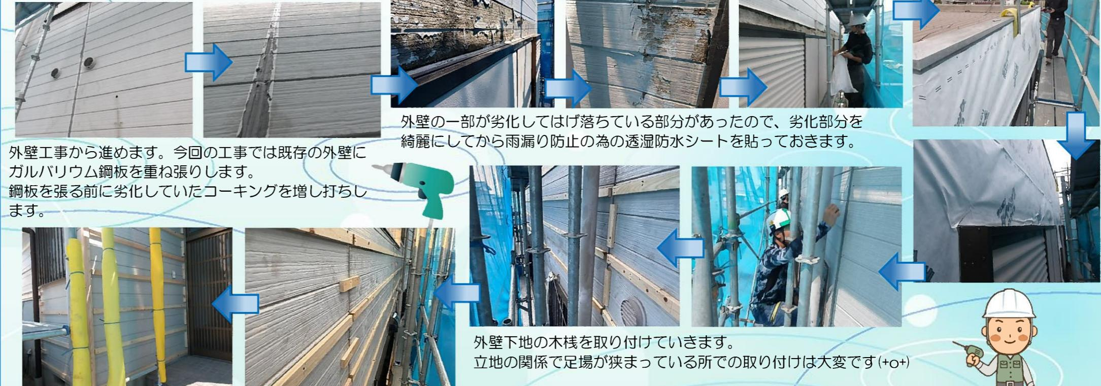
外壁の一部が劣化してはげ落ちている部分があったので、劣化部分を綺麗にしてから雨漏り防止の為の透湿防水シートを貼っておきます。
