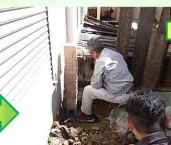
給排水管を繋げていきます。
