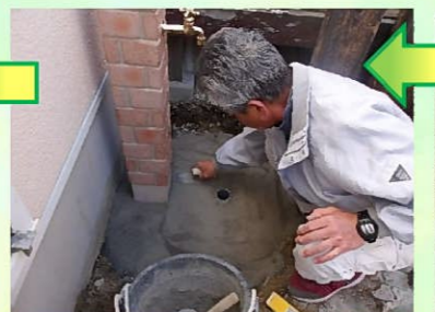
再度、立水栓を水平器で確認しながら生コンで固定します。
