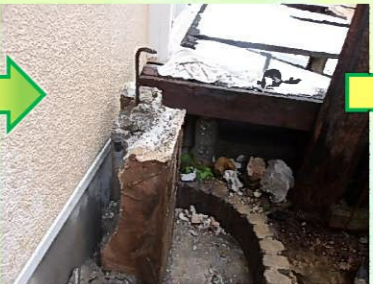
立水栓の一部を解体撤去し、止水しました。
