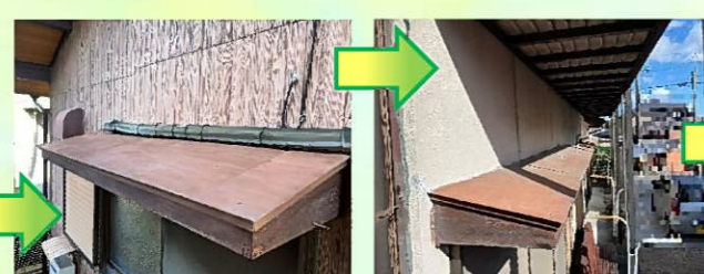
劣化により塗装の剥がれや錆がある状態でした。
