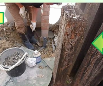
再度、立水栓を水平器で確認しながら生コンで固定します。
