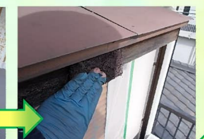
既設の塗装や汚れや錆などを研磨して落としていきます。
