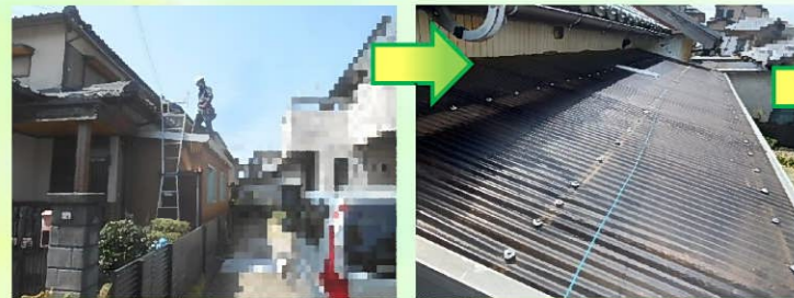
劣化が進んでいた既設屋根を撤去します。
