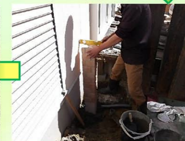
再度、立水栓を水平器で確認しながら生コンで固定します。
