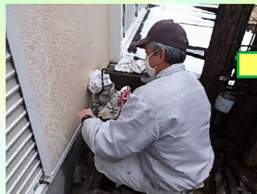
立水栓の一部を解体撤去し、止水しました。
