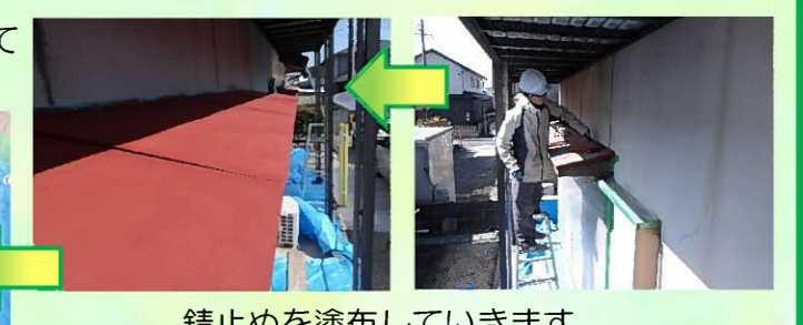
錆止めを塗布していきます。
