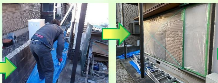
錆止めの後、1回目を塗りその後2回目を塗って仕上げます。
