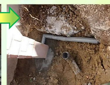
給排水管を繋げていきます。
