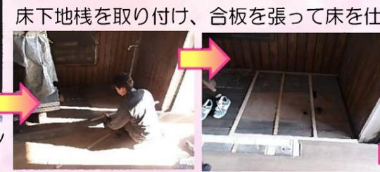
床下地棧を取り付け、合板を張って床を仕上げ、新調したシンクを仮置きしておきます。
