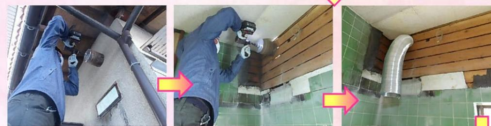
新たに取り付ける換気扇用のダクト工事です。屋外側と室内側からコア抜きを行い、ダクト管を取り付けます。屋外側にはベントキャップを取り付け、ベントキャップ周辺をシリコンコーキングをして完成です。
