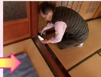
アルミタイプの敷居レールを取り付けていきます。
