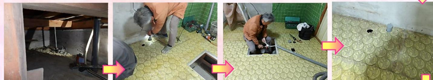
新調するシステムキッチンに合わせて給水給湯管、排水管、ガス配管をし直しました。床下に潜っての工事は大変です(+o+)
