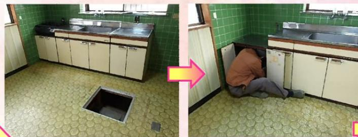
流し台を撤去するために支障があるガスと水道の配管を撤去します。
