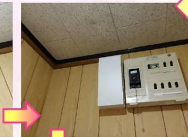
増設した分電盤から配線を台所側へ配線していきます。
