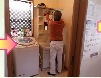
水栓金具下部から 水漏れしている 状態でした。
