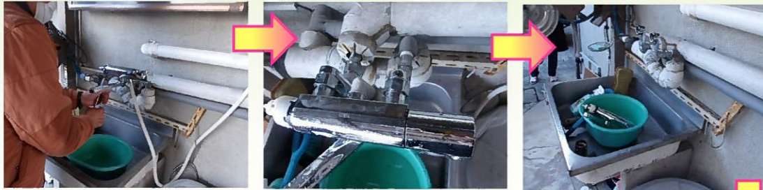
破損した水栓金具を取り外します。
