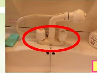
水栓金具下部から 水漏れしている 状態でした。
