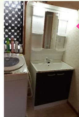
洗面化粧台取り替え 工事完了です(^^) /
