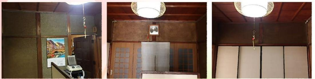
玄関奥の間の壁も玄関ホールと同じ桧の小幅板風羽目板で仕上げます。
