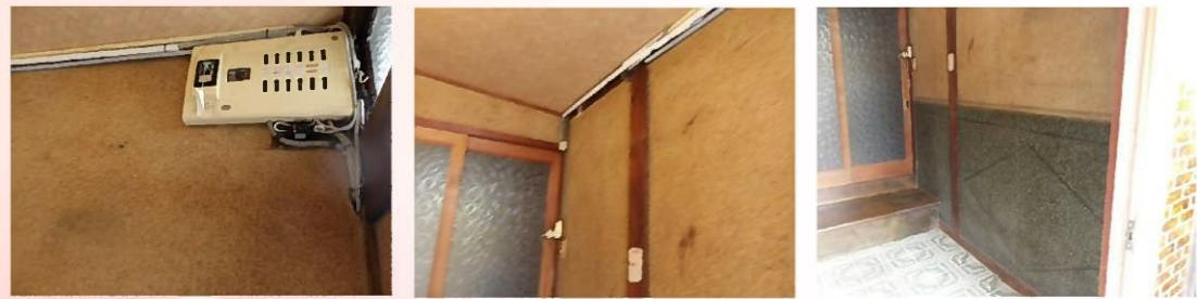
分電盤から何本も増設された配線を整理し、壁は桧の小幅板風羽目板で仕上げて露出していた配線を壁の中へ隠します。
