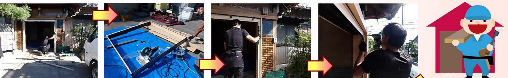
カバー工法で取り替えるので、ガラス戸と敷居レール部分を撤去して既存の建具枠に新たに枠を取り付けます。
