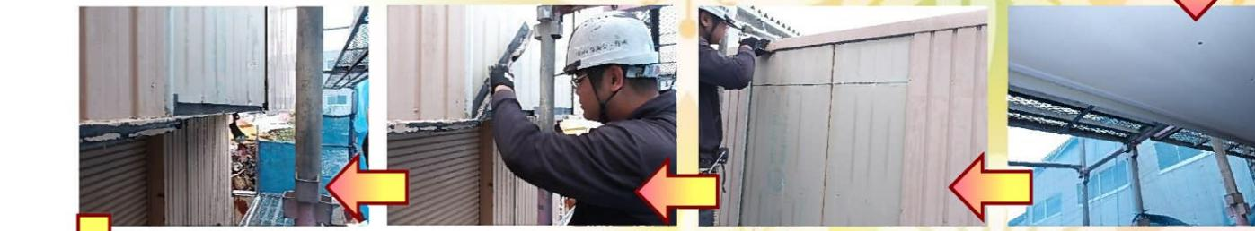
破損していた部分の鋼板を撤去していきます。
