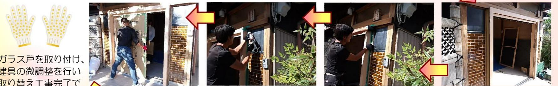
ガラス戸を取り付け、建具の微調整を行い取り替え工事完了です(^^)
