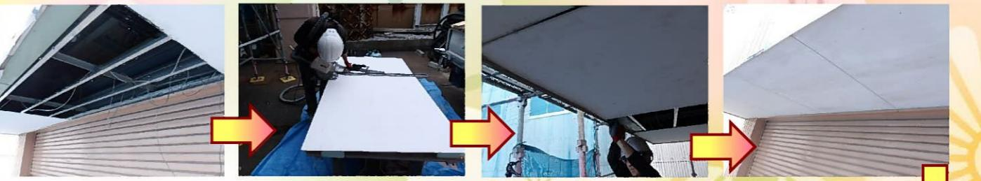
破損していた部分の軒天井を撤去し、新たに張り直しました。
