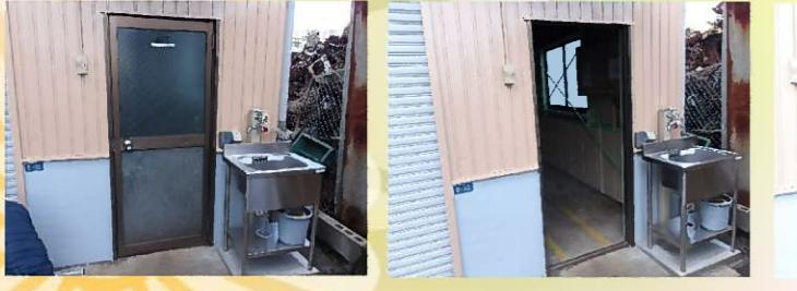
傷んできていた既存のドアを撤去し、新しいドアを取り付けます。
