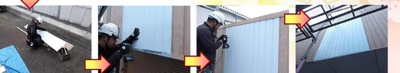
新たに張る鋼板を加工し、一枚ずつ張って仕上げます。
