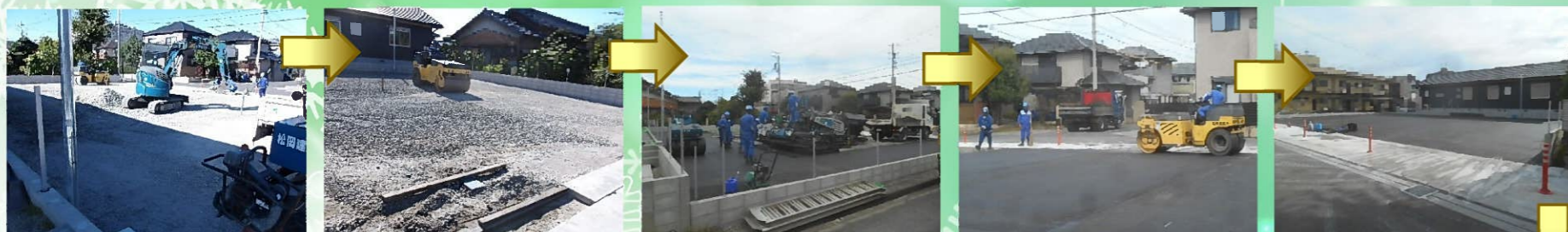
月極駐車場側にはアスファルトを敷設します。ローラー車で碎石を締め固めます。
