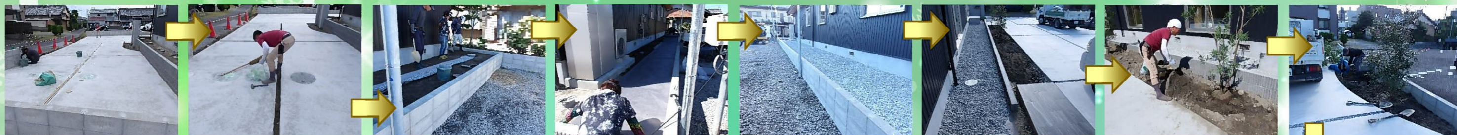
養生期間が終わり、型枠をばらします。
