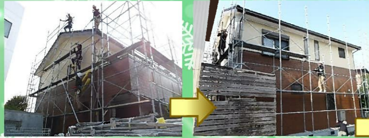
足場を撤去します。
