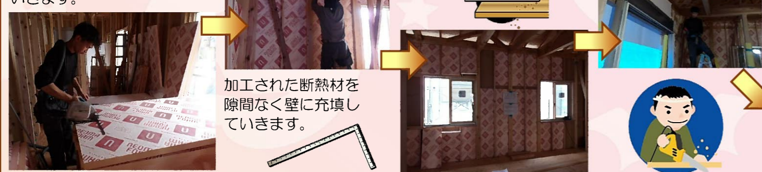
屋根の部分に断熱材を充填し、気密テープを貼っていきます。
