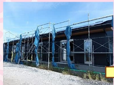
足場の撤去工事です。
