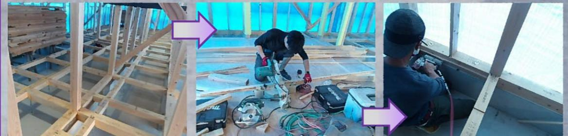
床断熱材受けの木桟を取り付けていきます。
