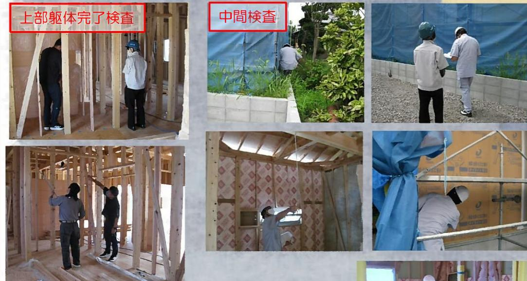
どちらの検査委員さんも図面を基に敷地に対して建物が図面通り配置されているか、耐力壁の釘のピッチや金物の取り付け位置は適正に行われているかなど細かくチェックしていきます。
