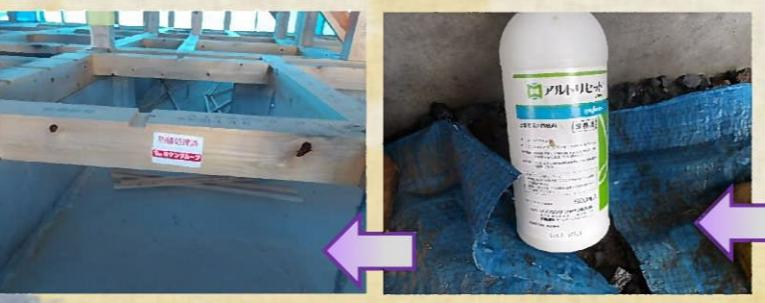
最後に土壤処理用防蟻剤を散布し、処理済みラベルを貼って防蟻処理工事完了です(^)/
