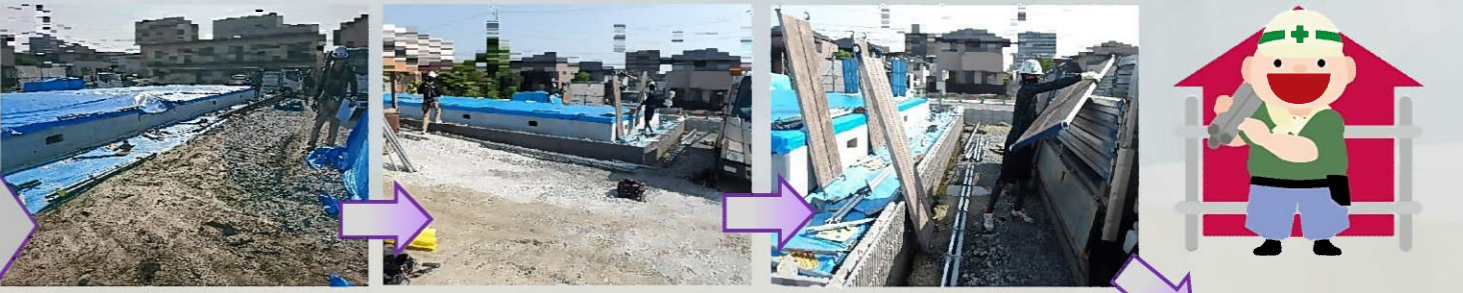
足場の鋼管が運び込まれ、職人さんたちが手際よく足場を組み上げていきます。今回は平屋建てなのでいつもより足場の高さは低めです。
