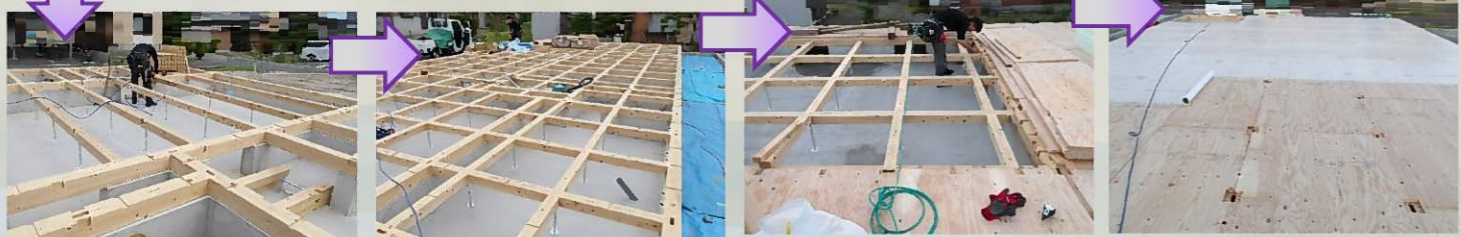
床パネルを仮敷し、養生用のシート、その上にブルーシートを張っていきます。
