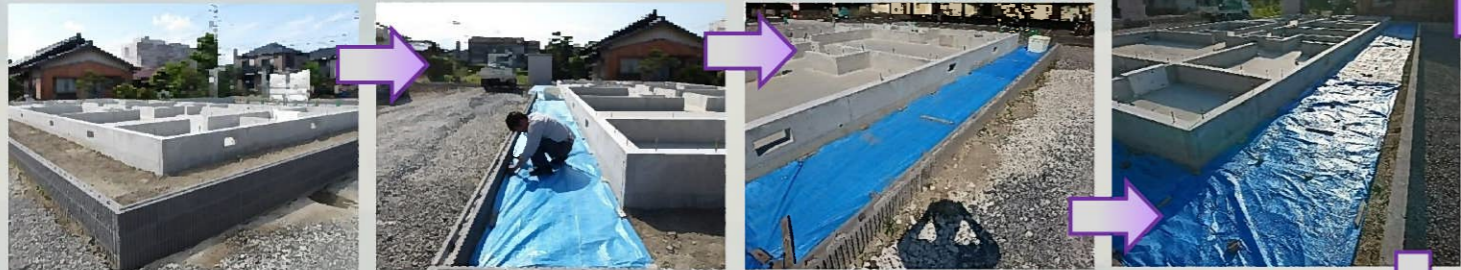
基礎の周りにブルーシートで養生します。
