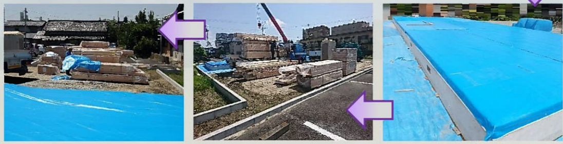
床パネルを仮敷し、養生用のシート、その上にブルーシートを張っていきます。
