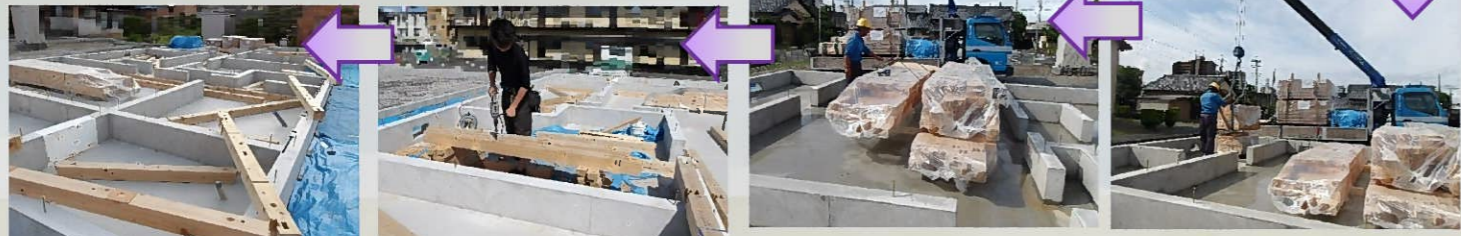
床の構造材が搬入されてきました。
