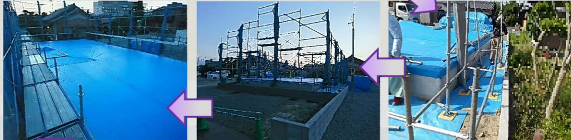
足場の鋼管が運び込まれ、職人さんたちが手際よく足場を組み上げていきます。今回は平屋建てなのでいつもより足場の高さは低めです。
