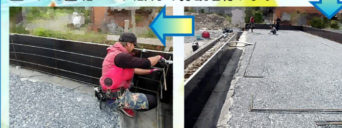
生コンが乾いたら型枠を組み、配筋を組んでいきます。
