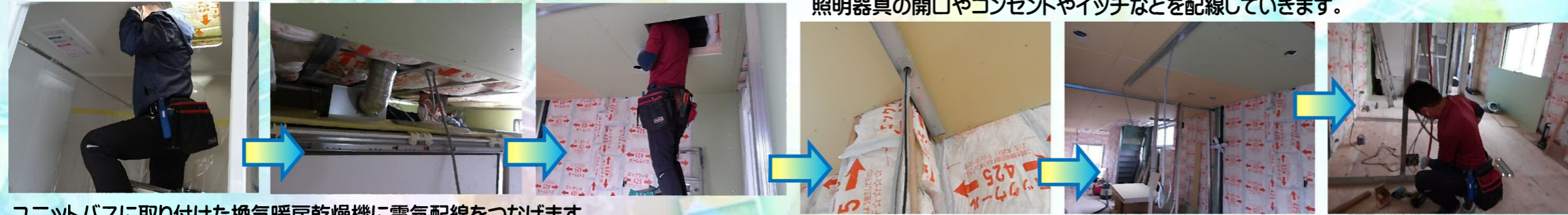
ユニットバスに取り付けた換気暖房乾燥機に電気配線をつなげます。
