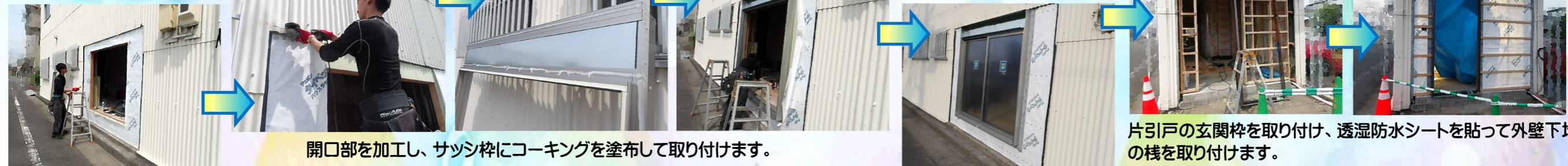
新規窓サッシを取り付けます。
