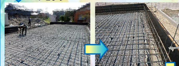
生コンが乾いたら型枠を組み、配筋を組んでいきます。
