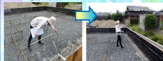
配筋組完了です！ 第三者検査機関の検査員の基礎配筋検査を受ける前に弊社建築士が図面を基に自主検査を行います。
