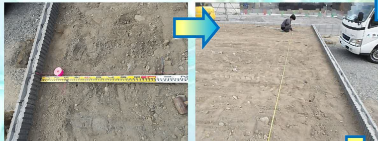
地盤調査用の地縄張りを行います。
