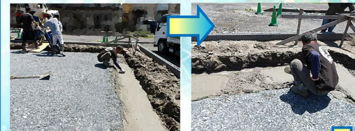
生コンで基礎ベース部分の打設を行います。
