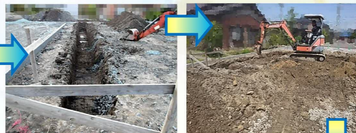
丁張が済んだら掘削と鋤取り作業を行い、敷地を均していきます。
