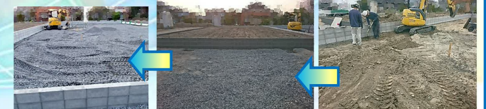
基礎ベース部分が乾いたら、ブロックを積んでいきます。
