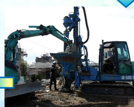
重機が設置され、砕石を柱状に地中に締め固めながら詰め込みます。今回の工事では50本の砕石杭を打ってもらいます。
