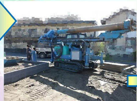
砕石杭を打つ場所にし印が付けられています。
