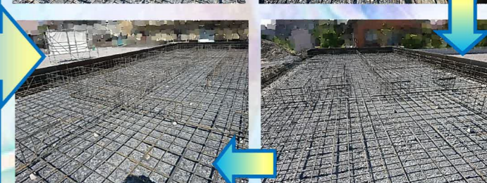
配筋組完了です！ 第三者検査機関の検査員の基礎配筋検査を受ける前に弊社建築士が図面を基に自主検査を行います。
