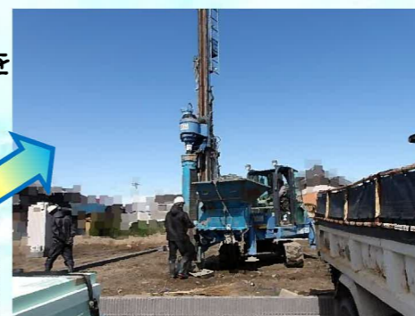
重機が設置され、砕石を柱状に地中に締め固めながら詰め込みます。今回の工事では50本の砕石杭を打ってもらいます。
