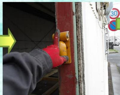
根太組みを行う前に既設開口部の鉄骨の錆止め塗装を行います。既設塗材のケレン掛けを行い、ペーパーで取れない剥離部分はハンマーで叩いて浮かせて捲りました。
