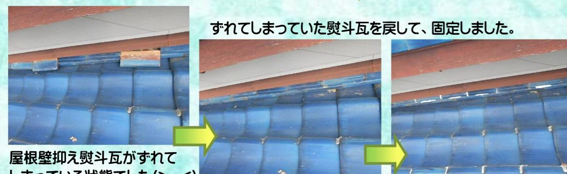
屋根壁抑え熨斗瓦がずれてしまっている状態でした(>\_<)
