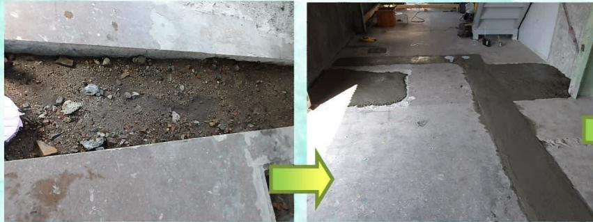
打設部分に水を撒いて生コンを打設して完了です。
