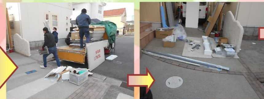
ユニットバスの資材が搬入され、梱包材を外していきます。
