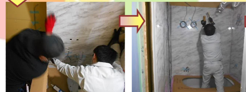
壁パネルを仮設置していきます。
