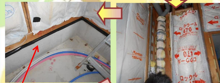
基礎ハツキン換気部にも気密テープを貼って通気を遮断します。
