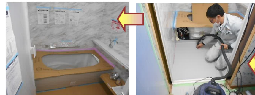
掃除を行い、コーキングを充填し、ユニットバス設置完了です！
