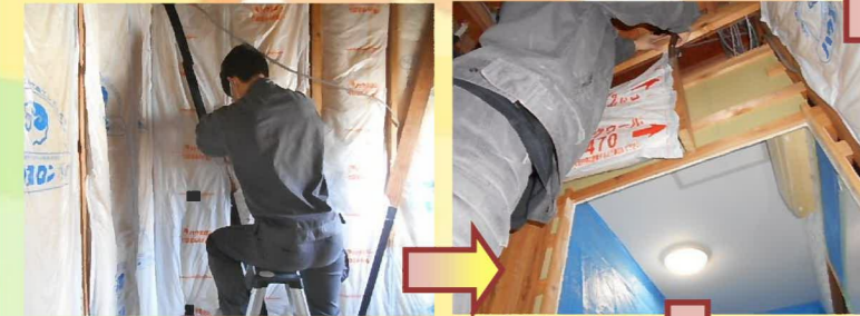
電気工事後、断熱材を充填し直します。
