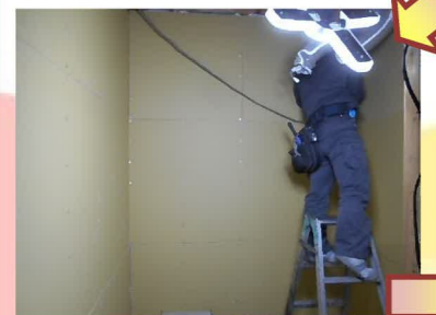
石膏ボード貼り完了です！
