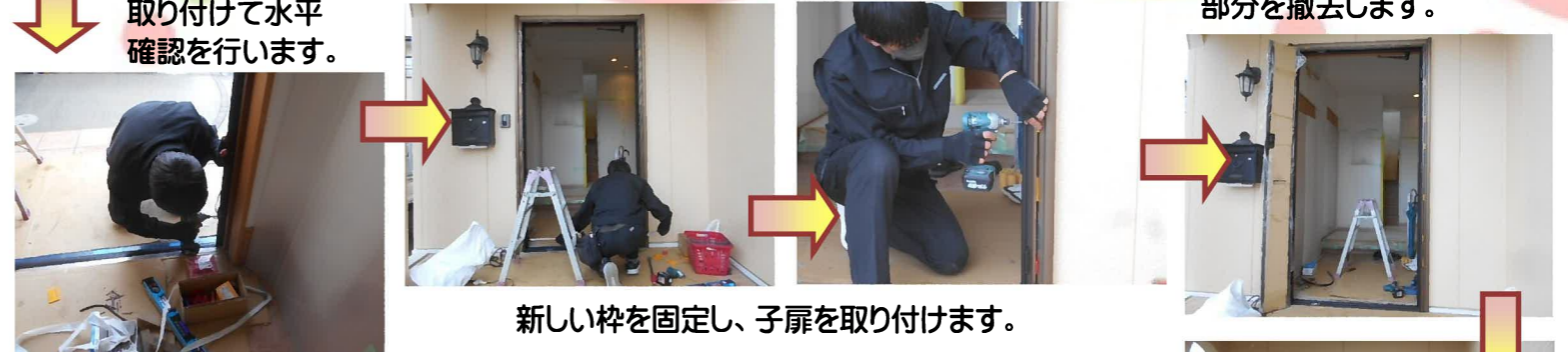
既設沓摺の水平と既設枠の垂直確認を行います。
