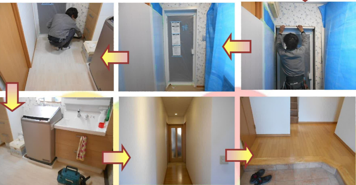
樹脂枠を加工して 取り付けます。
