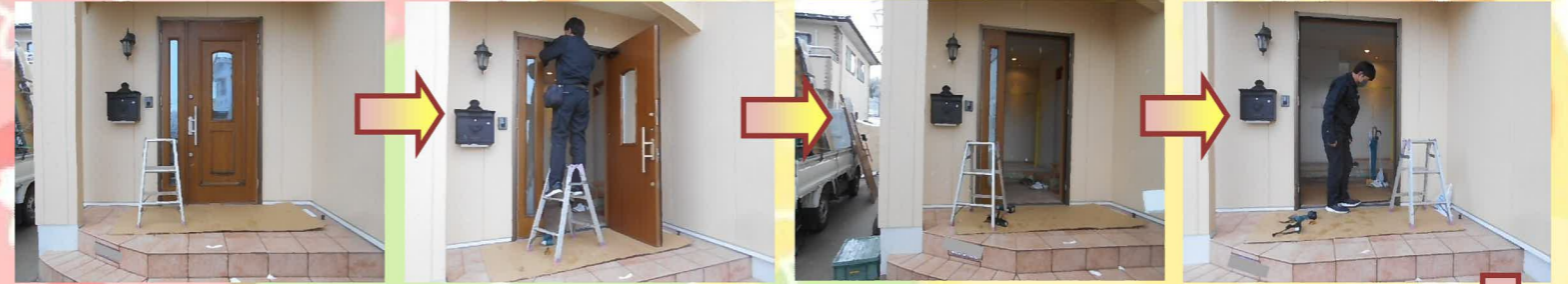
既設ドアを撤去します。
