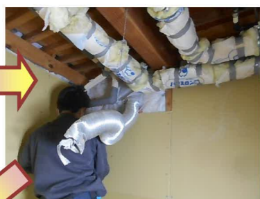
黙々と「石膏ボード」を貼っていきます。
