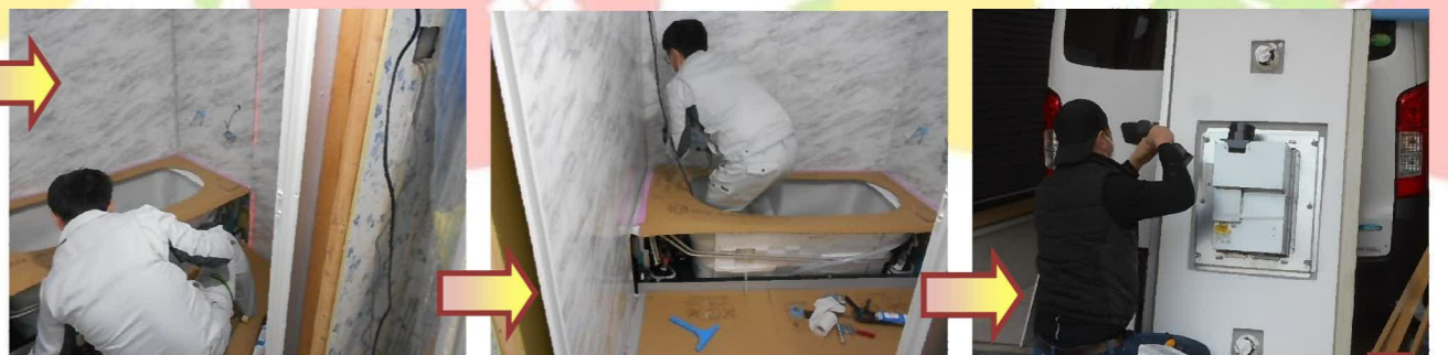
パネルが垂直に設置されているか確認してから固定します。
