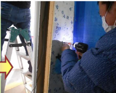
浴室暖房乾燥機のリモコンを壁に取り付けます。
