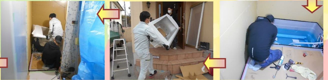
床組の上に浴槽断熱をセットし、浴槽を慎重に搬入し取り付けます。
