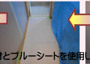
床に養生紙を敷いて、その上に緩衝材、更にその上に養生板を敷いて養生テープでしっかり固定します。
