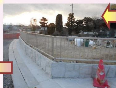
フェンス支柱をセメントで固定します。
