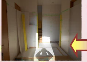
床に養生紙を敷いて、その上に緩衝材、更にその上に養生板を敷いて養生テープでしっかり固定します。
