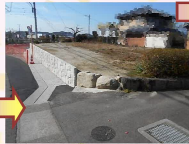
新しくできた擁壁はフェンス等を設置する為の穴がない擁壁だったので、擁壁横に穴を掘って坪基礎を設置しました。
