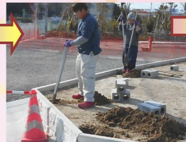
新しくできた擁壁はフェンス等を設置する為の穴がない擁壁だったので、擁壁横に穴を掘って坪基礎を設置しました。
