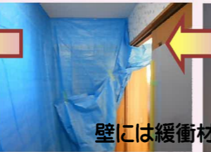
床に養生紙を敷いて、その上に緩衝材、更にその上に養生板を敷いて養生テープでしっかり固定します。
