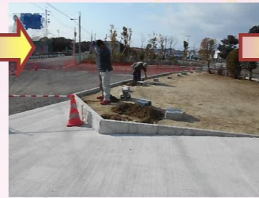
新しくできた擁壁はフェンス等を設置する為の穴がない擁壁だったので、擁壁横に穴を掘って坪基礎を設置しました。
