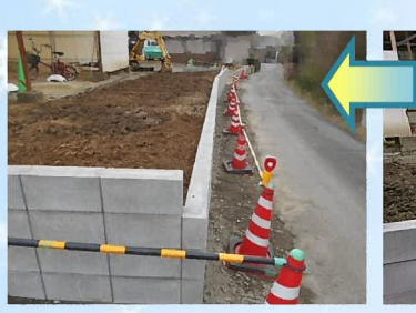
道路側の埋め戻し後、敷地内の埋め戻しを行い、重機で均します。
