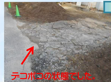
テコボコになっていた乗入面を解体撤去していきます。
