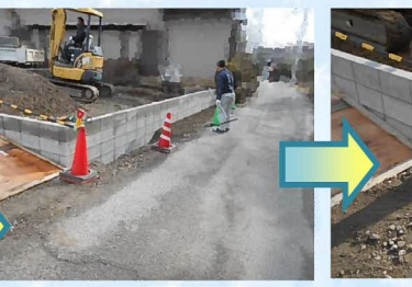
道路側の埋め戻し後、敷地内の埋め戻しを行い、重機で均します。
