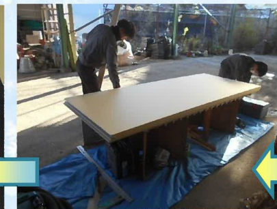
「石膏ボード」を運び込まれ、寸法を確認しながら天井と壁に貼っていきます。
