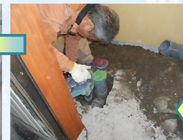
和式から洋式便器に変更するので、配管場所を移動します。
