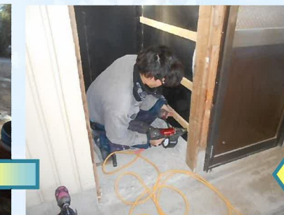
壁下地の棧を取り付けていきます。
