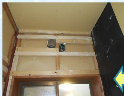
「石膏ボード」を運び込まれ、寸法を確認しながら天井と壁に貼っていきます。
