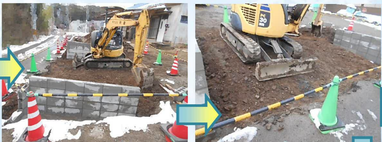
テコボコになっていた乗入面を解体撤去していきます。
