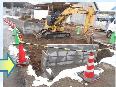
東側の一部分のブロックを積んで一旦ブロック積み工事はお休みします。
