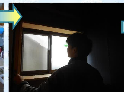
仮組みを行い、寸法を確認します。
