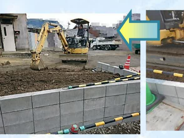
道路側の埋め戻し後、敷地内の埋め戻しを行い、重機で均します。
