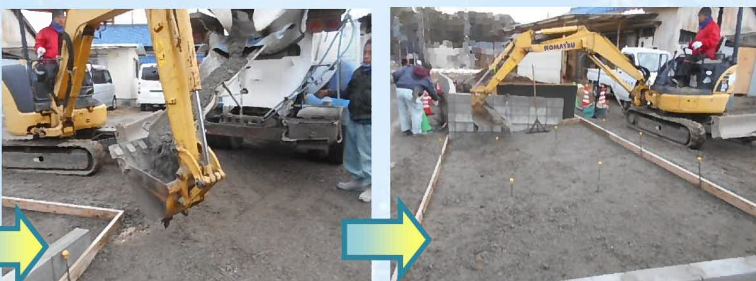
透水性コンクリートが運び込まれ、重機を使って敷設していきます。
