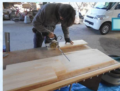
窓枠を加工していきます。
