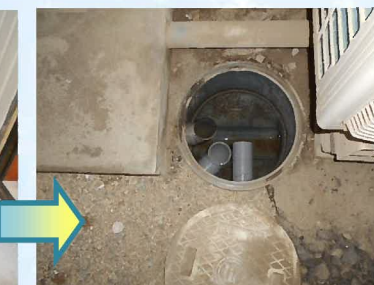
新設した排水管を既設柵に接続します。
