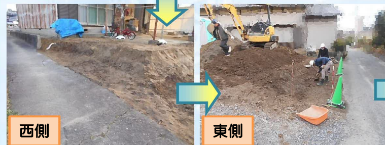
物置小屋が済んだら西側と東側の既存のブロック塀と玉石を撤去していきます。
