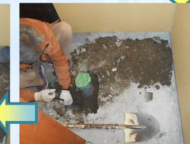
和式から洋式便器に変更するので、配管場所を移動します。
