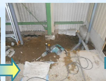
新設した排水管を既設柵に接続します。
