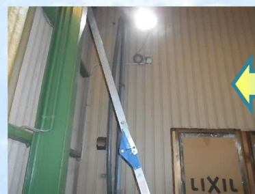
2階手洗への新設配管も敷設しました。
