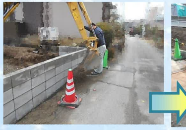
道路側の埋め戻し後、敷地内の埋め戻しを行い、重機で均します。
