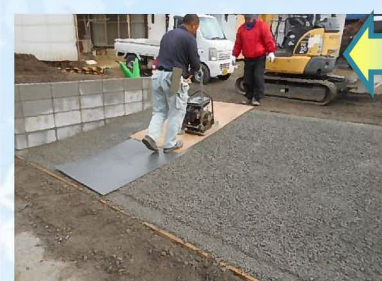
透水性コンクリートを均し、端部は手動ダンパーを使い、最後に打設した面を転圧機で締め固めました。
