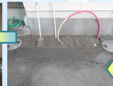
埋設管を敷設し埋め戻しました。
