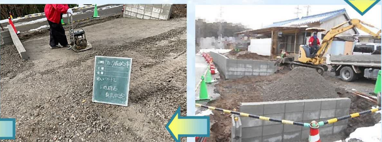
砕石を敷設し、転圧機を使ってしっかり締固めます。
