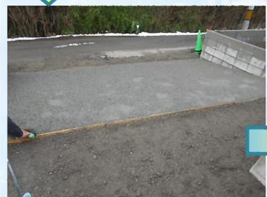
乾燥養生期間後、打設面にコンパネを敷設しておきます。
