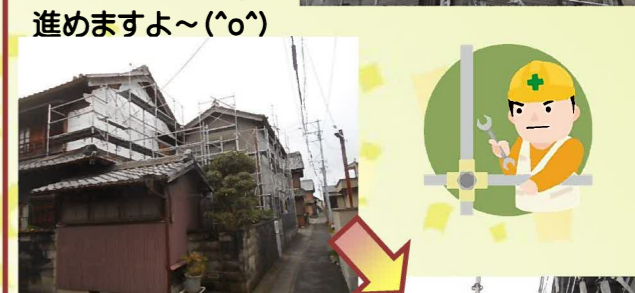
離れ家 職人さん達が手際よく足場を組み上げていきます。 雨の中、事故やケガもなく、無事足場の設置完了です！足場が設置されたのでサクサク工事を進めますよ~(^o^) 既存の躯体や土壁を破損しないように慎重に撤去していきます。 トタンを撤去し、露わになった土壁に透湿防水シートを貼っておきます。
