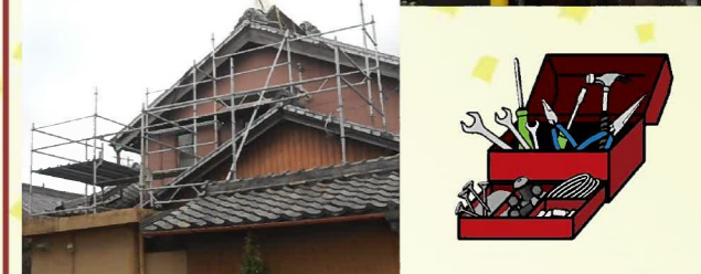
離れ家 職人さん達が手際よく足場を組み上げていきます。 雨の中、事故やケガもなく、無事足場の設置完了です！足場が設置されたのでサクサク工事を進めますよ~(^o^) 既存の躯体や土壁を破損しないように慎重に撤去していきます。 トタンを撤去し、露わになった土壁に透湿防水シートを貼っておきます。
