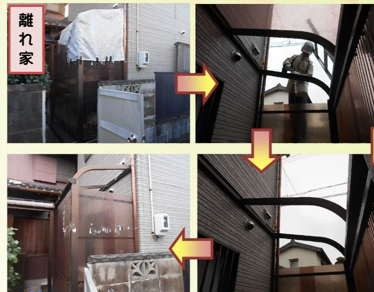
雨の降る中、足場の設置工事です。鋼管が運び込まれます。 職人さん達が手際よく足場を組み上げていきます。 雨の中、事故やケガもなく、無事足場の設置完了です！足場が設置されたのでサクサク工事を進めますよ~(^o^)
