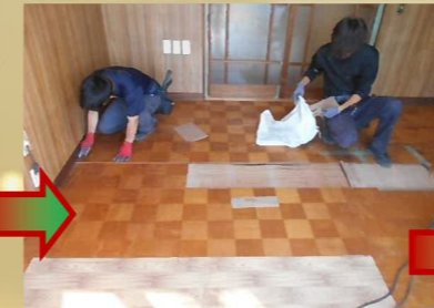
床板を剥がして、床組も撤去していきます。
