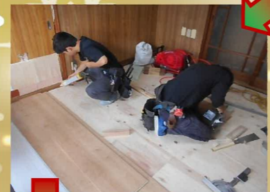
フロア-材を加工しながら 一枚ずつ貼っていきます。
