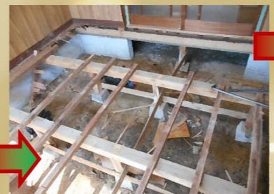
床板を剥がして、床組も撤去していきます。
