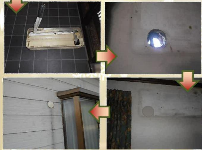
エアコンと室外機を撤去し、壁の穴を塞いで撤去工事完工です(^o^)
