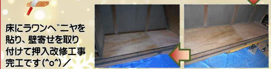
床にラワンベニヤを貼り、壁寄せを取り付けて押入改修工事完工です(^\_^\v
