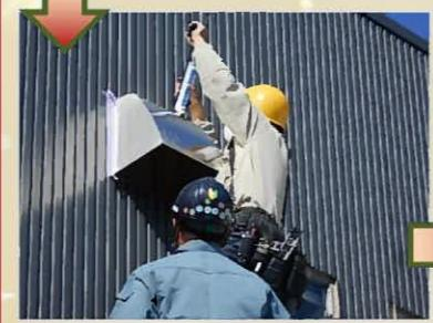
室内側に開けた開口部に合わせて外壁を撤去し、フートを取り付けます。
