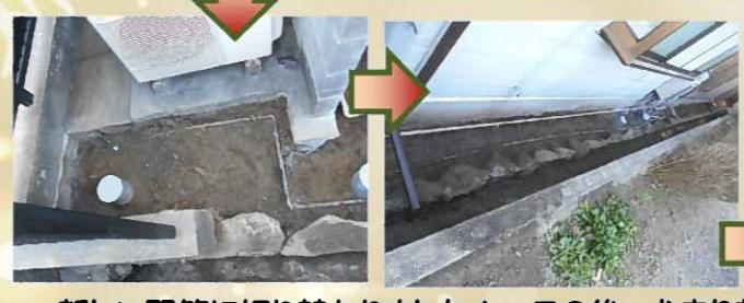
新しい配管に切り替わりました！ この後、犬走り部分は透水コンクリートで仕上げます。
