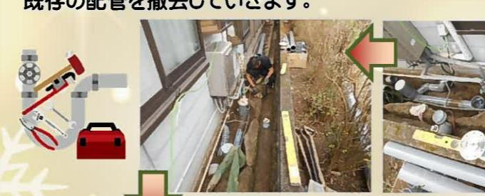
新しい配管を取り付け埋め戻していきます。
