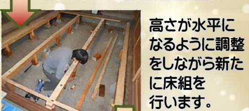
高さが水平になるように調整をしながら新たに床組を行います。
