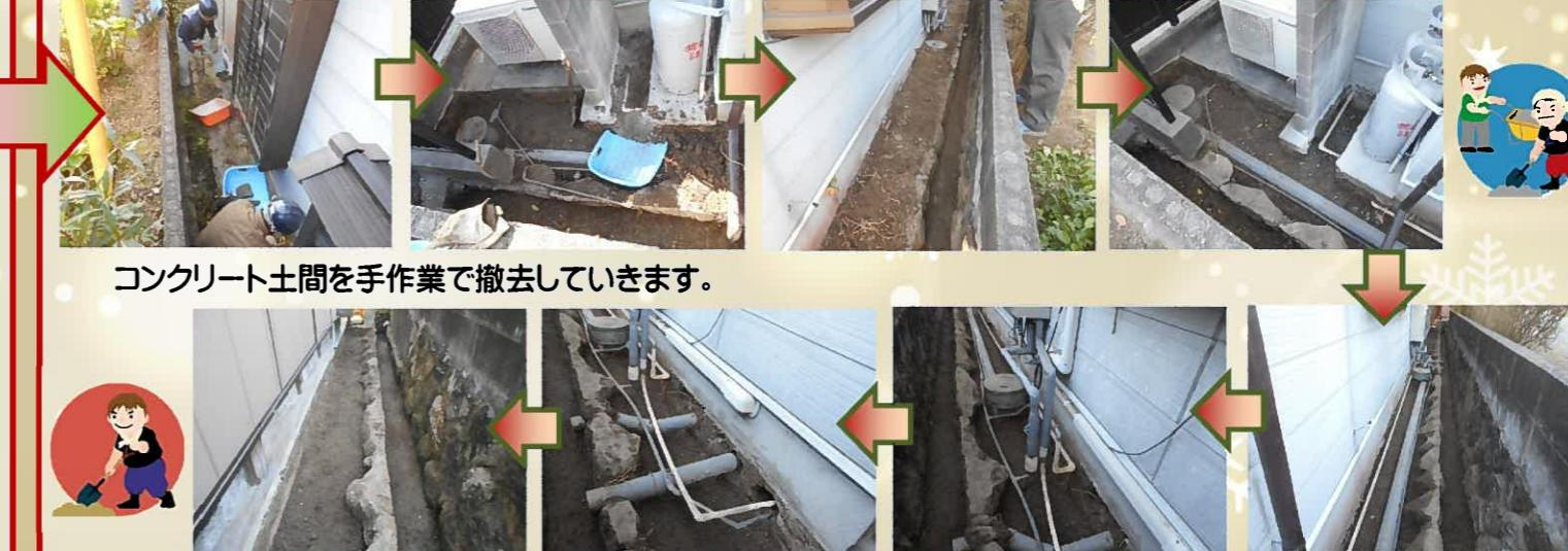
コンクリート土間を手作業で撤去していきます。
