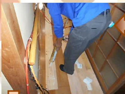
出入りする床にキズなどを付けない様に養生します。
