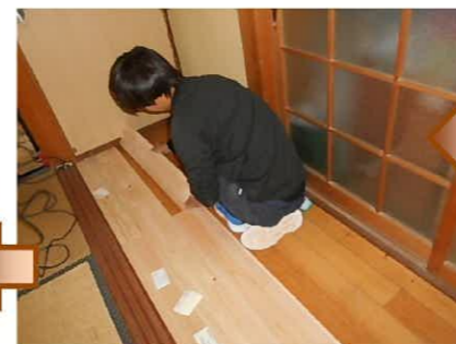
床板を一枚ずつ加工しながら既存の床板に貼っていきます。
