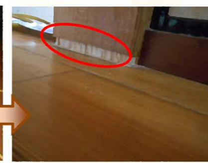
床板をはめ込む為柱の一部分を撤去します。この作業、大工さん達は『柱の首切り』っていうそうです…(^_^;)
