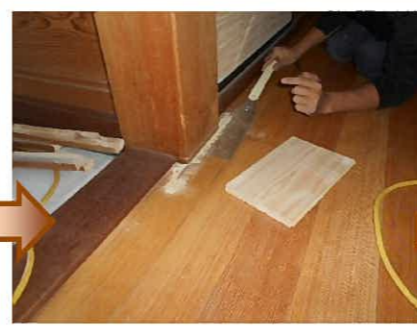
床板をはめ込む為柱の一部分を撤去します。この作業、大工さん達は『柱の首切り』っていうそうです…(^_^;)
