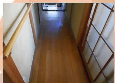
現状の床板の上に新たに床板を増し貼りします。
