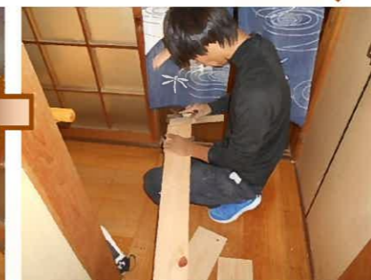
床板を一枚ずつ加工しながら既存の床板に貼っていきます。
