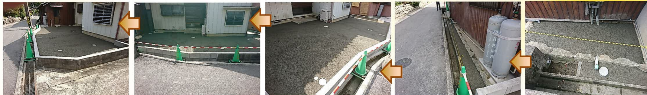
透水性コンクリート打設完了です！ 乾くまで立ち入らないようにコーンなどを配置しておきます。
