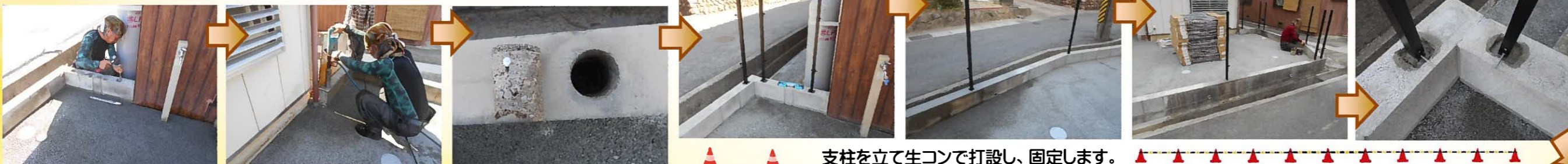
フェンス設置工事です！ まずは支柱を立てる為、ブロック基礎に穴を開けていきます。
