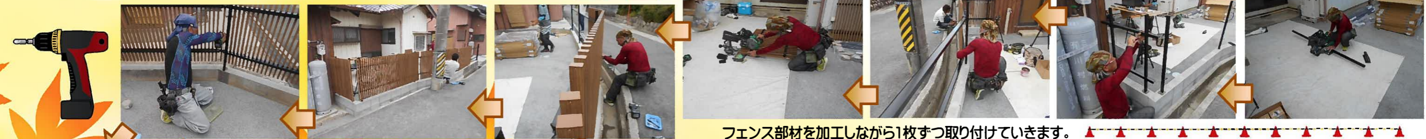
フェンス設置工事です！ まずは支柱を立てる為、ブロック基礎に穴を開けていきます。
