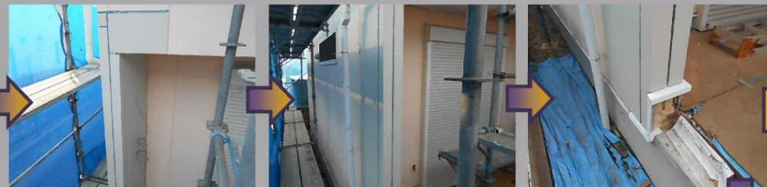
外壁材を寸法に合わせてカットし、貼っていきます。
