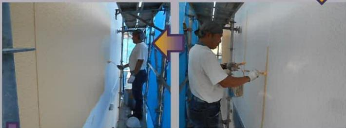
仕上げ塗りは2回行います。まずは1回目の仕上げ塗り。刷毛を使ってジョイント部分を塗り、その後ローラーを使って全体を塗っていきます。
