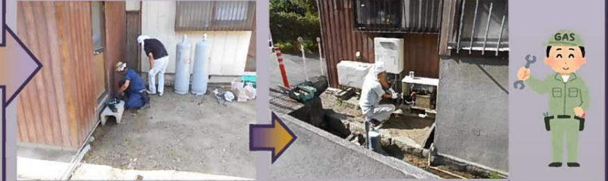
既設のガス管を撤去していきます。合わせて灯油暖房機も撤去します。
