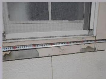
飾り窓枠も劣化が進み、表面が剥がれ落ちてしまっている
