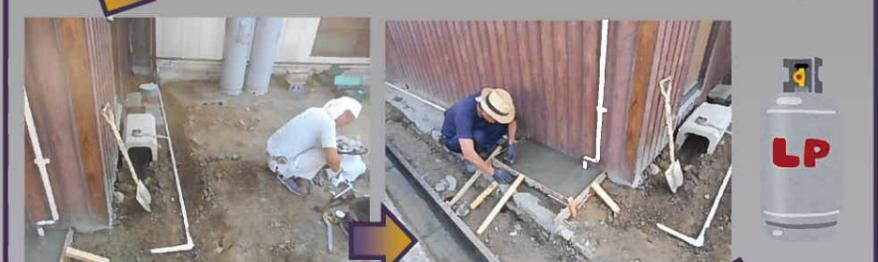
新しいガス管を設置していきます。ガスボンベの位置も変えるので生コンで打設し、設置場所を作り直します。
