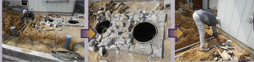
浄化槽を解体撤去し、新たな管を下水管へ繋げていきます。
