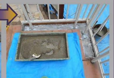
フェンス取り付け後、型枠を組み、タイル床高さまでセメントで埋めます。
