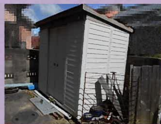
スチール物置も 解体撤去 します。
