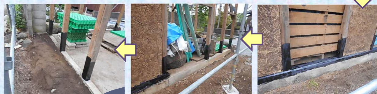
土壁と骨組みだけになった肥料小屋の土台部分に防腐剤を塗布していきます。
