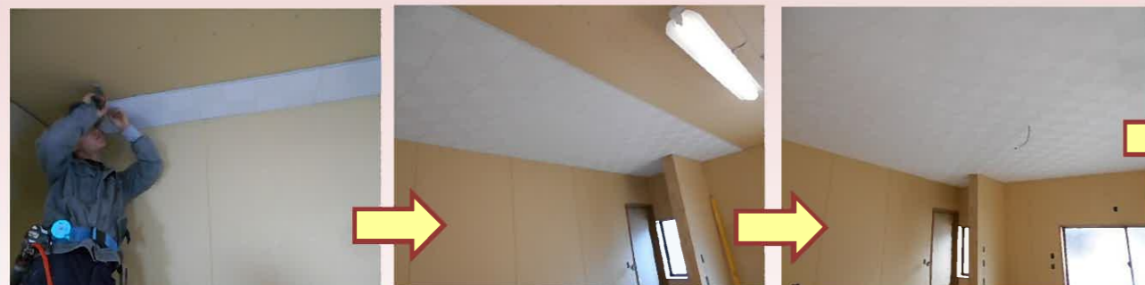
今回の工事ではDKと洗面所の天井はクロスではなく、調湿性能があり、吸音性能も併せ持つ天井材で仕上げます。
