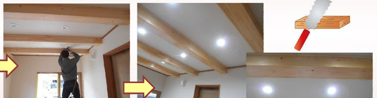
廻縁を取り付け、塗装を行い化粧梁工事完了です。 綺麗に仕上がりました(o^o^)/ なかなか感じの良いリビングになりましたよ～ 完工写真をお楽しみに！
