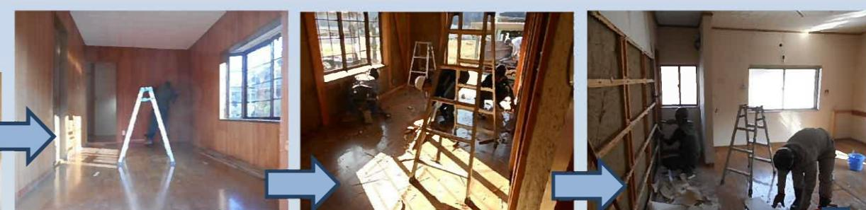
残す部分の柱や壁などが破損しないように慎重に解体撤去工事を進めます。
