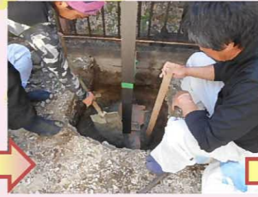
仮固定してあった支柱部分を水平器を使って真っすぐ立っていることを確認しながら生コンで固定し、固まるまで添え木を立てておきます。
