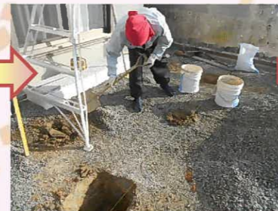
テラスを設置する位置を確認し、支柱を立てる為の穴を掘っていきます。
