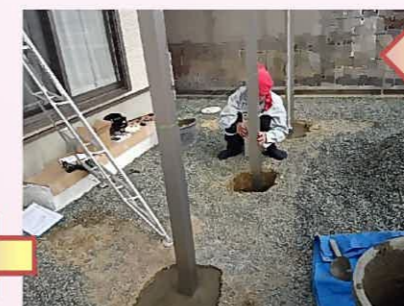
仮固定してあった支柱を真っ直ぐに立っていることを水平器で確認しながら生コンで固定していきます。
