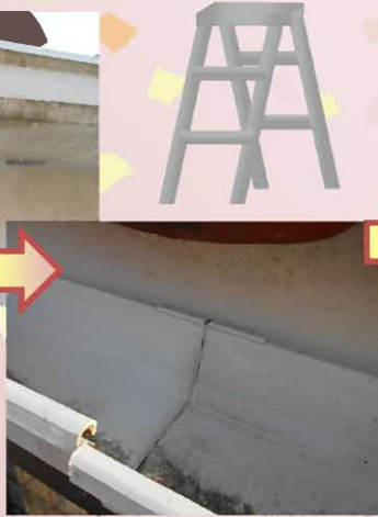
ジョイントの一部が破損し、軒樋が外れ掛けている状態でした。
