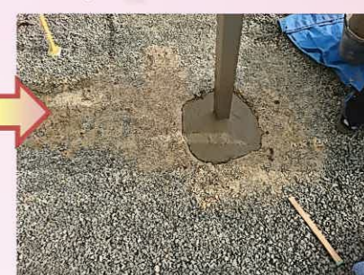
仮固定してあった支柱を真っ直ぐに立っていることを水平器で確認しながら生コンで固定していきます。
