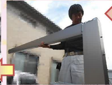
支柱を立て、土のうでしっかり仮固定します。
