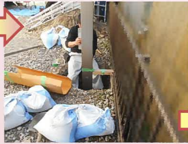
仮固定してあった支柱部分を水平器を使って真っすぐ立っていることを確認しながら生コンで固定し、固まるまで添え木を立てておきます。
