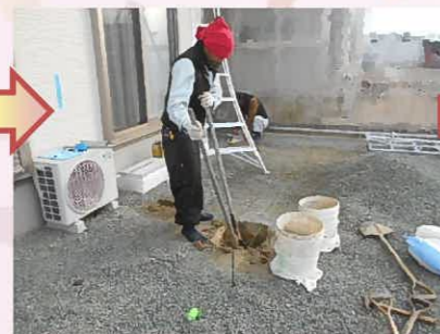
テラスを設置する位置を確認し、支柱を立てる為の穴を掘っていきます。
