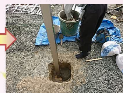
仮固定してあった支柱を真っ直ぐに立っていることを水平器で確認しながら生コンで固定していきます。
