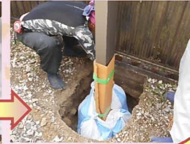
支柱を立て、土のうでしっかり仮固定します。
