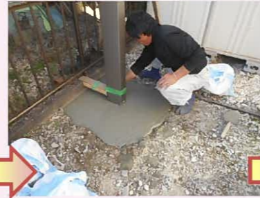
仮固定してあった支柱部分を水平器を使って真っすぐ立っていることを確認しながら生コンで固定し、固まるまで添え木を立てておきます。
