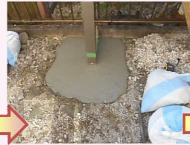
仮固定してあった支柱部分を水平器を使って真っすぐ立っていることを確認しながら生コンで固定し、固まるまで添え木を立てておきます。
