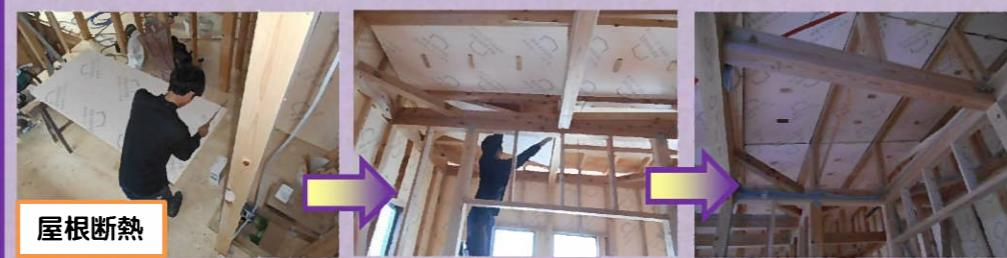
断熱材を一枚ずつ加工しながら屋根部分に断熱材を充填していきます。
