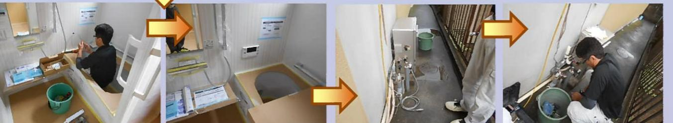
ユニットバスのガスの接続配管を行い、リモコンを取り付け、新しい給湯器に接続します。
