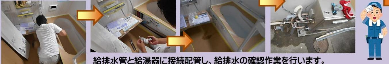
給排水管と給湯器に接続配管し、給排水の確認作業を行います。
