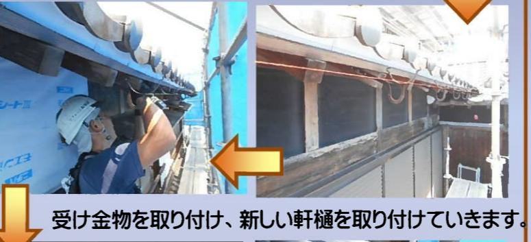
受け金物を取り付け、新しい軒樋を取り付けていきます。
