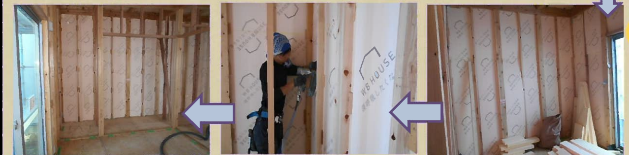
綺麗に納まりました(^_^)v 床の断熱材を充填した時と同じように断熱材が浮いてこないように木枠で押えていきます。
