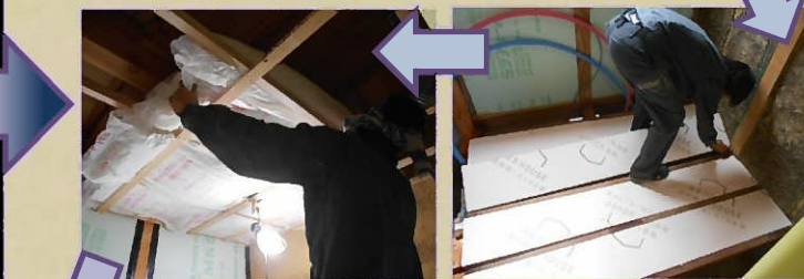
天井、壁、床に断熱材を充填していきます。
