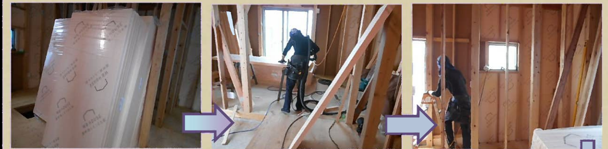
現場に運び込まれた断熱材を壁にはめ込むサイズに加工しながら一枚ずつ充填していきます。
