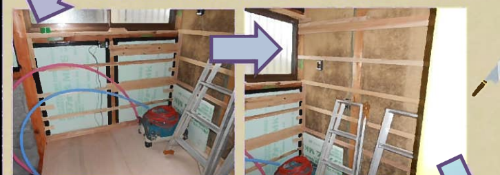
下地用の木桟を取り付けます。
