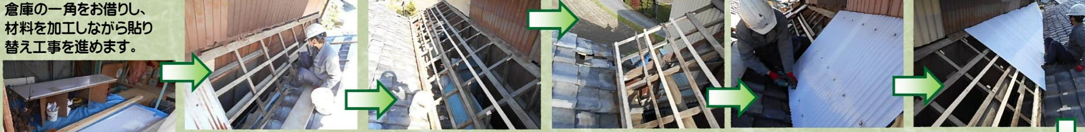
既存の塩ビ板を撤去し、木棟を補強していきます。
