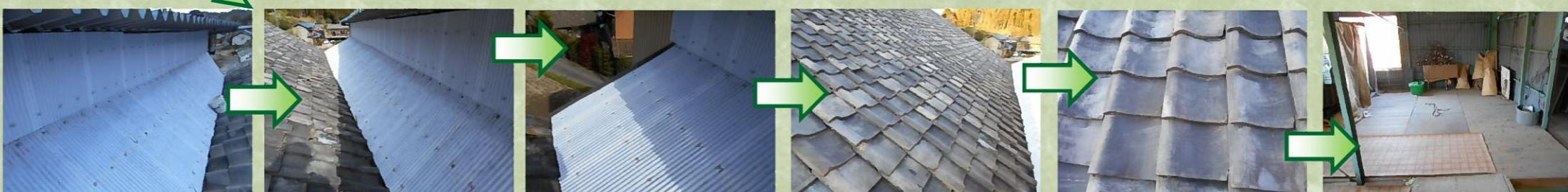
貼り替え工事完了です！綺麗に仕上がりました。そして最後に破損している屋根瓦を差し替え、お借りしていた倉庫の清掃を行い、全ての工事が完了です！
